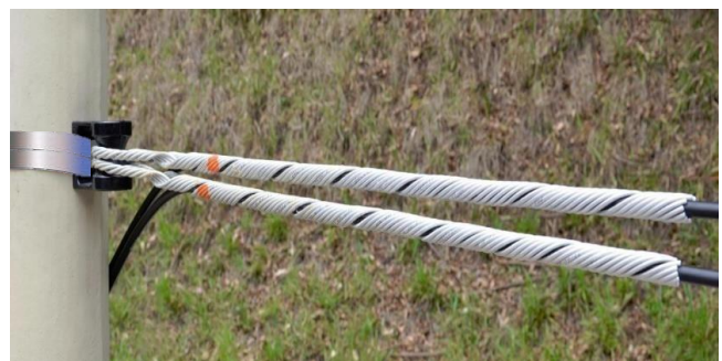
Instalación del Soporte de Retención
