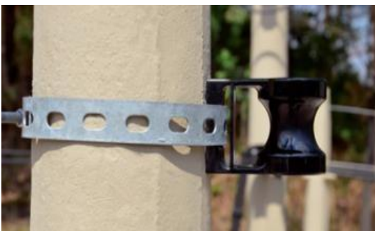
Instalación del Soporte de Retención
