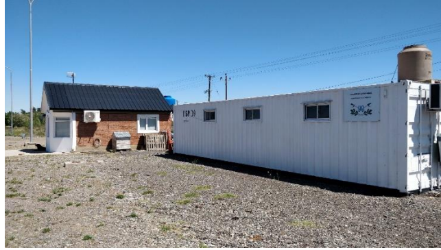
Registro Fotográfico: Instalaciones perteneciente a Gendarmería Nacional.
