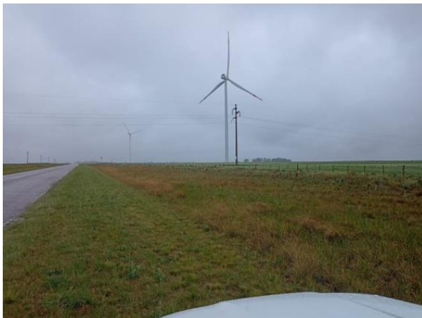
Registro Fotográfico: Línea de 132 kV.
