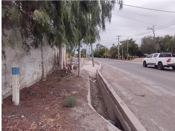
Registro fotográfico. Inicio de traza.
