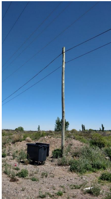
Registro Fotográfico: Tendido de fibra óptica, paralelo a la ruta.
