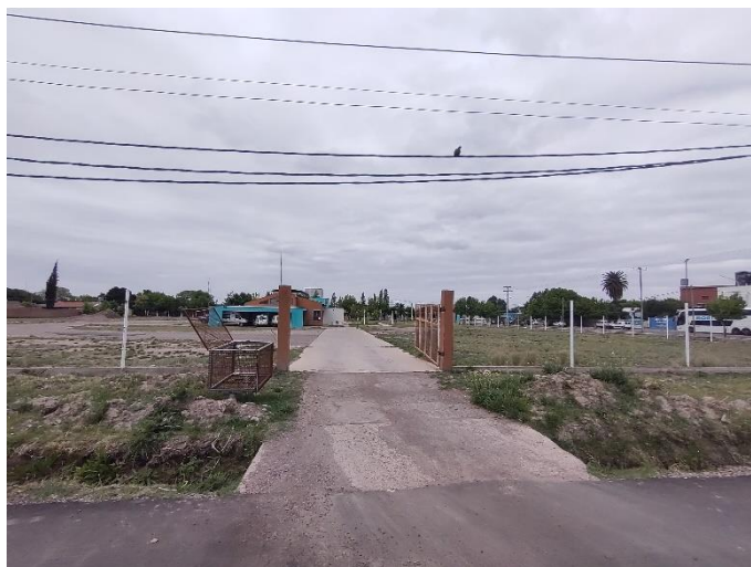
Registro fotográfico. Finalización traza. Micro hospital.
