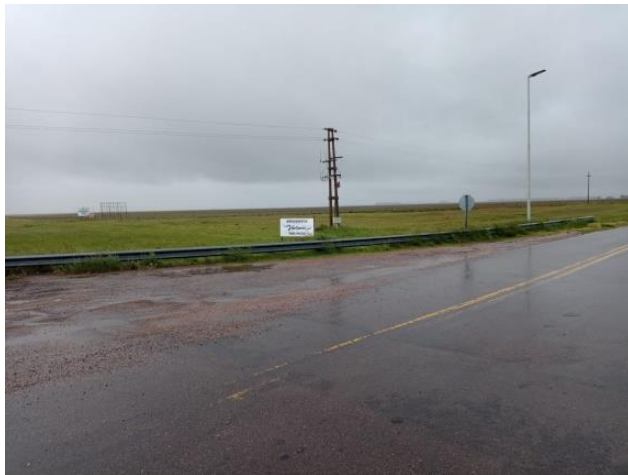
Registro Fotográfico: Línea aérea al comienzo de la traza.
