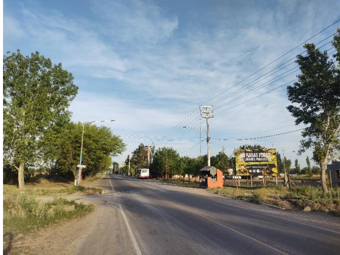
Registro Fotográfico: Inicio de traza.
