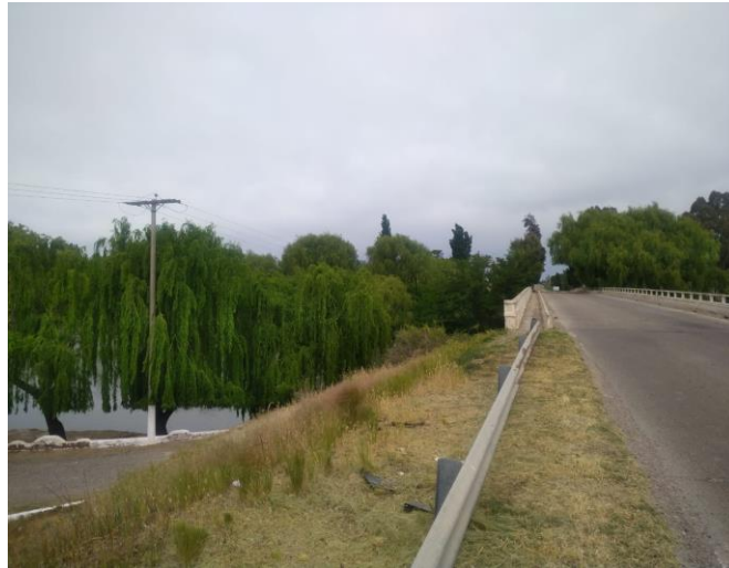
Registro Fotográfico: Puente brazo sur Rio Negro
