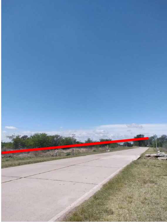
Registro Fotográfico: Continuación camino acceso La Cautiva.
