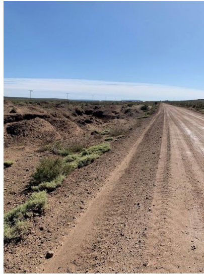
Registro Fotográfico: Banquina reducida
