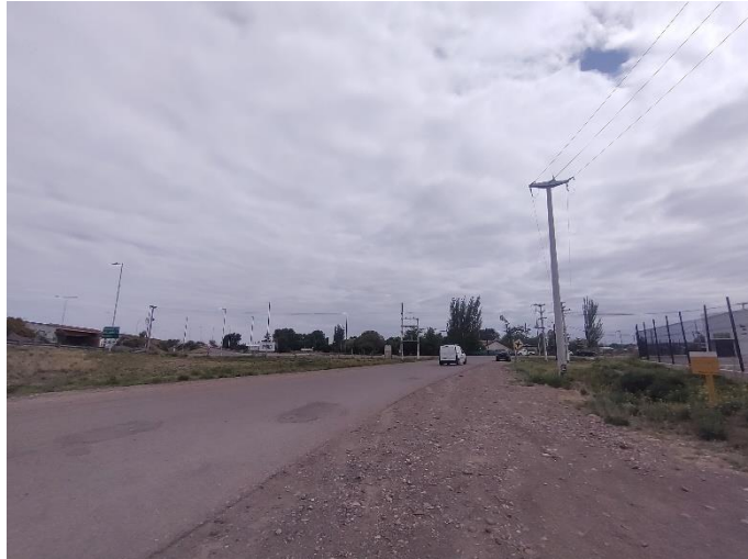
Registro fotográfico. Continuación calle s/n. Traza gasoducto.
