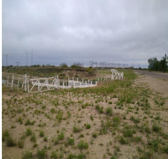
Registro Fotográfico: Puente canal de riego
