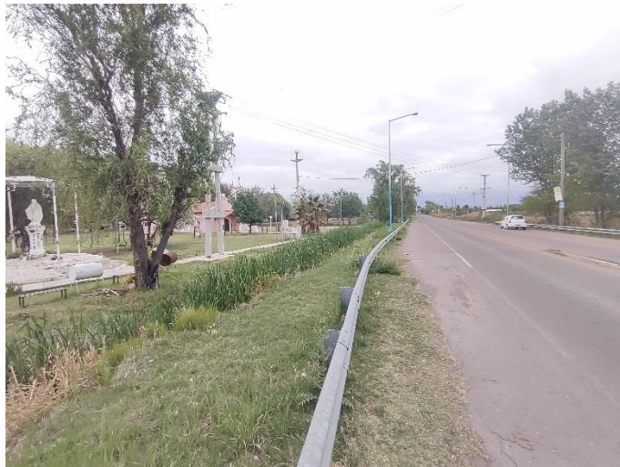
Registro fotográfico. Inicio de traza.
