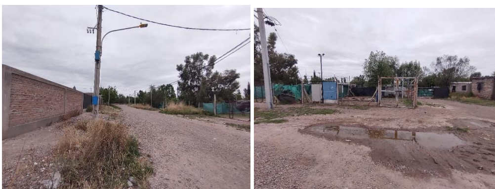
Registro fotográfico. Finalización traza.
