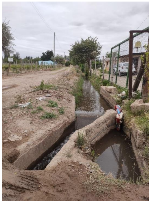
Registro fotográfico. Acequia.
