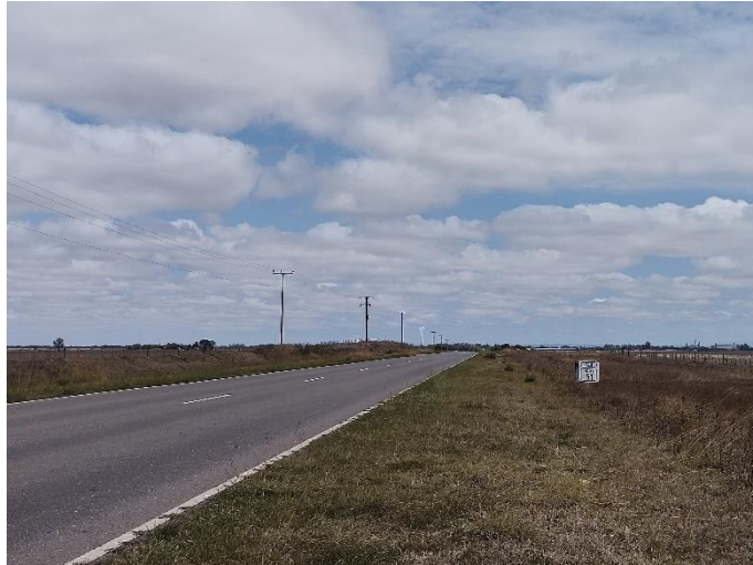
Registro Fotográfico: Continuación de la traza paralela a RP E79.
