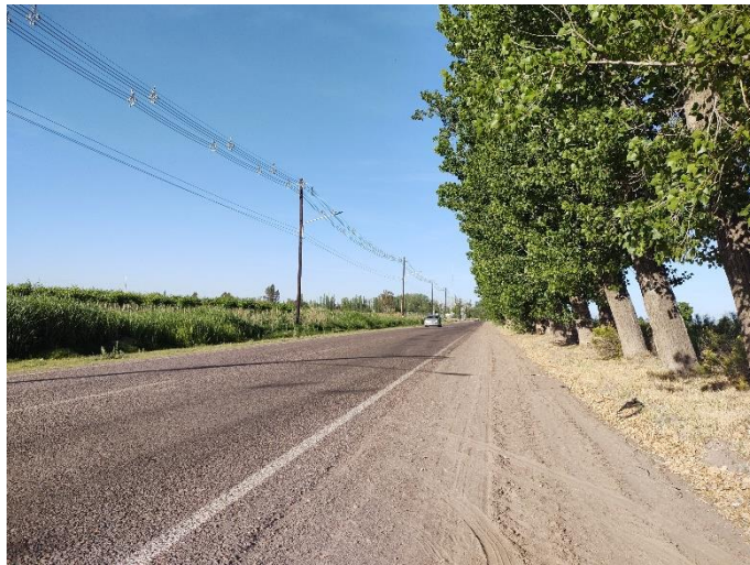
Registro Fotográfico: Continuación de traza por RP 36.
