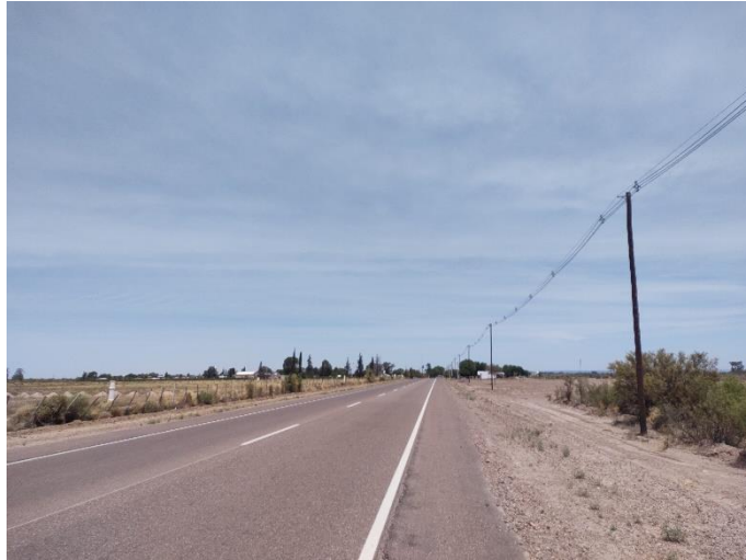
Registro Fotográfico: Continuación traza, Ruta Pcial. N° 71.
