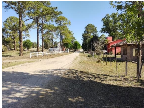
Registro Fotográfico: Traza, calle s/n, barrio residencial.
