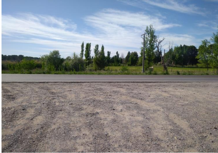
Registro Fotográfico: Tendido eléctrico del lado izquierdo de la ruta
