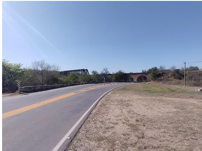
Registro Fotográfico: Cruce ramal (abandonado) RP E56.
