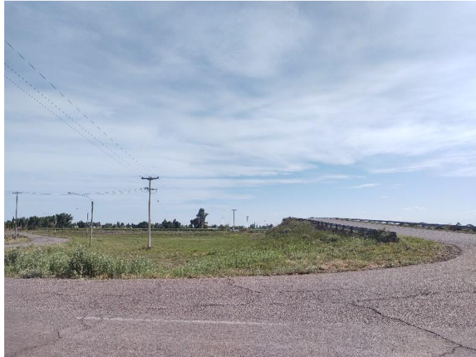
Registro fotográfico. Inicio de traza.
