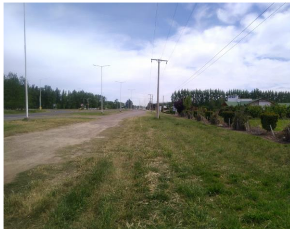
Registro Fotográfico: Tendido eléctrico RN 250
