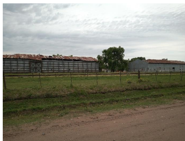
Registro Fotográfico: Terreno frente a Unidad Sanitaria. Lindante con línea de ferrocarril. Presencia de galpones.
