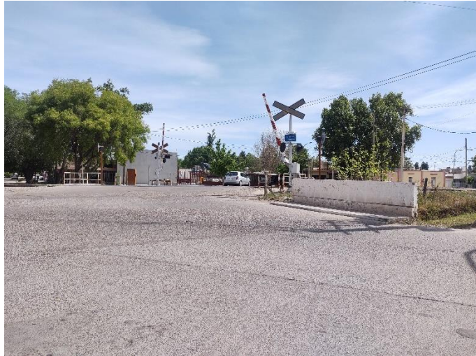
Registro Fotográfico: Cruce vía férrea, calle Perrupato.
