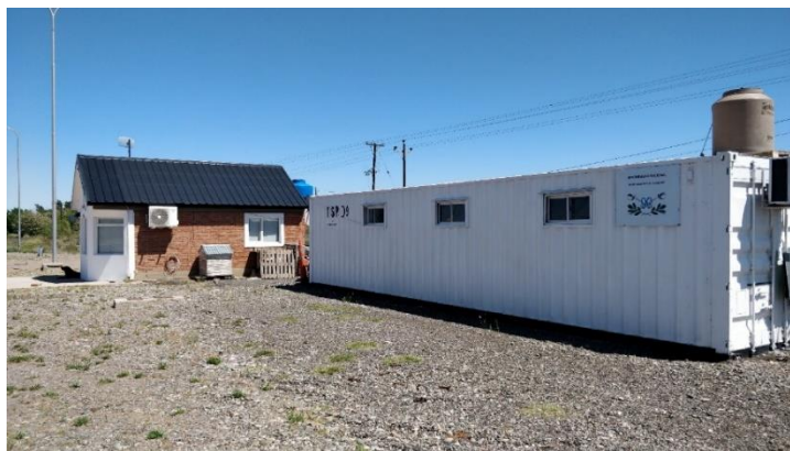
Registro Fotográfico: Imagen del espacio destinado a la instalación del Sitio.
