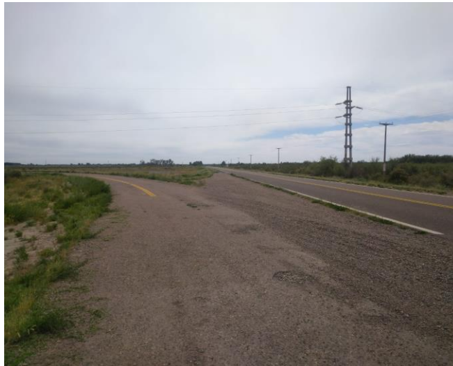
Registro Fotográfico: Cruce tendido eléctrico
