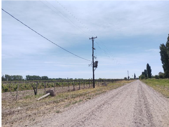
Registro Fotográfico: Calle s/n continuación traza.
