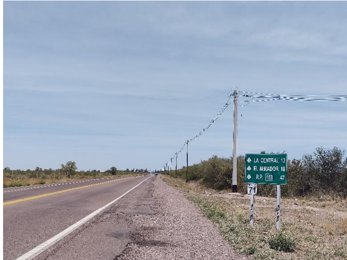
Registro Fotográfico: traza por Ruta Pcial. N°71.
