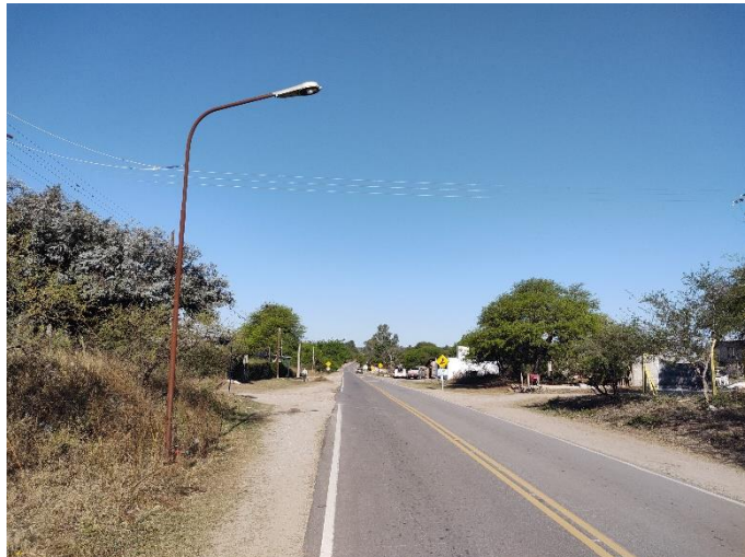
Registro Fotográfico: Finalización de traza en José de la Quintana.
