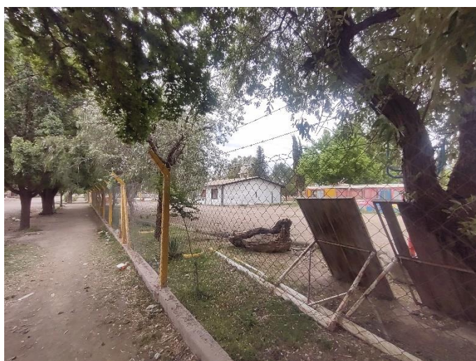
Registro fotográfico. Finalización de la traza. Polideportivo Municipal.
