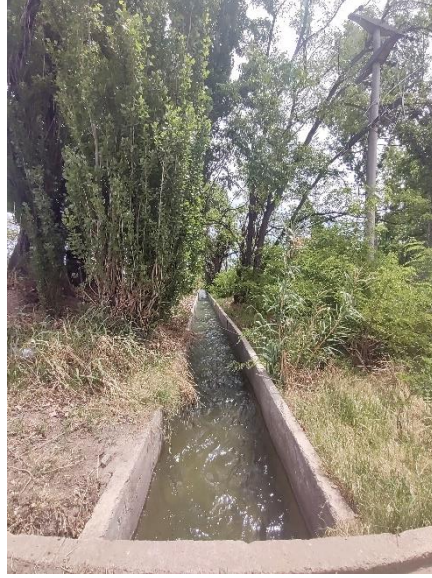
Registro Fotográfico: Cruce de acequia.
