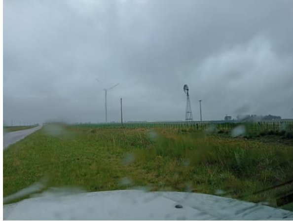
Registro Fotográfico: Línea Aérea de Media Tensión
