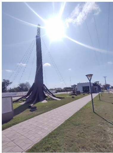
Registro Fotográfico: Terminal de ómnibus James Craik.
