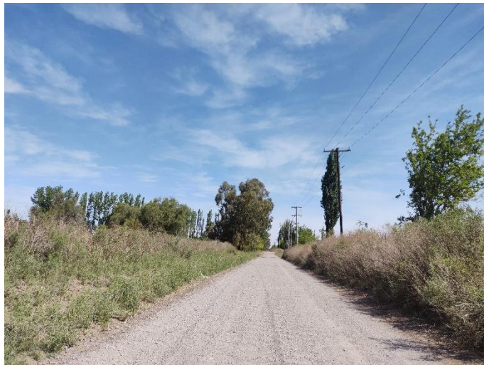
Registro Fotográfico: Continuación por calle San Juan no asfaltada.
