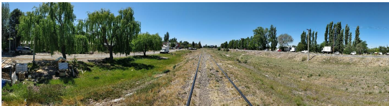
Registro Fotográfico: Recorrido desde lado izquierdo a derecho de la traza (60 metros de longitud)
