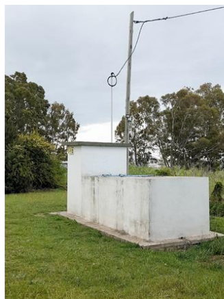
Registro Fotográfico: Foto Punto 13
