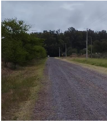
Registro Fotográfico: Vista del camino de acceso.
