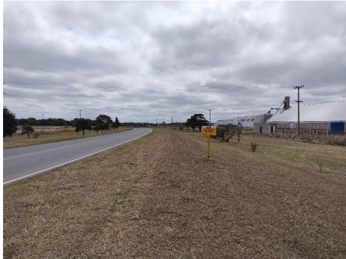
Registro Fotográfico: RP E79, aviso traza gasoducto.
