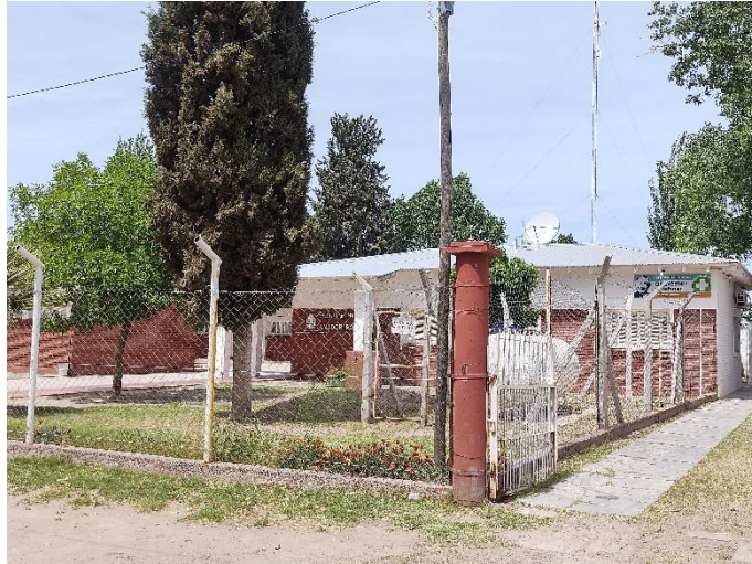
Registro Fotográfico: Escuela N° 1-26 “Amador Rodríguez”. Posta Sanitaria “Néstor Kirchner”.
