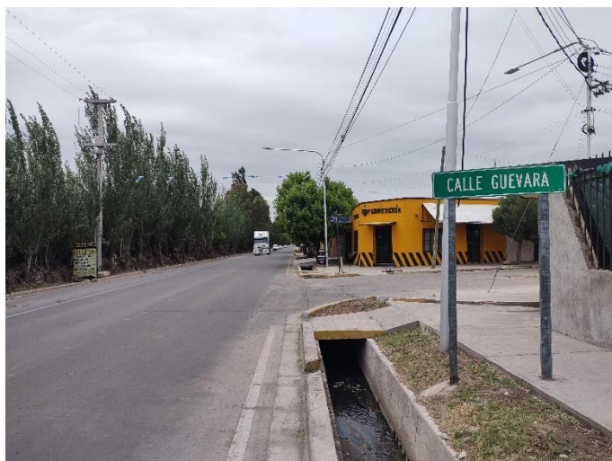
Registro fotográfico. Continuación traza calle Adriano Gómez.
