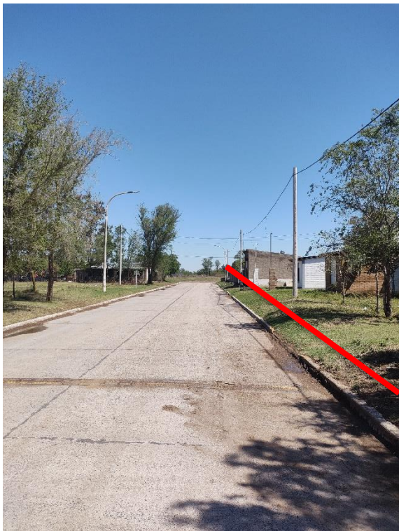
Registro Fotográfico: Calle Córdoba.
