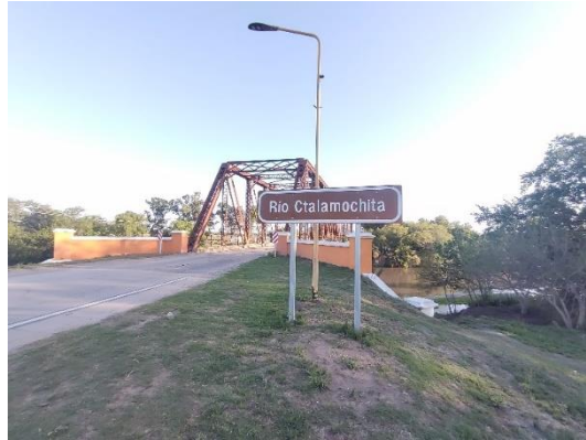
Registro Fotográfico. Puente sobre el Río Ctalamochita (Río Tercero).
