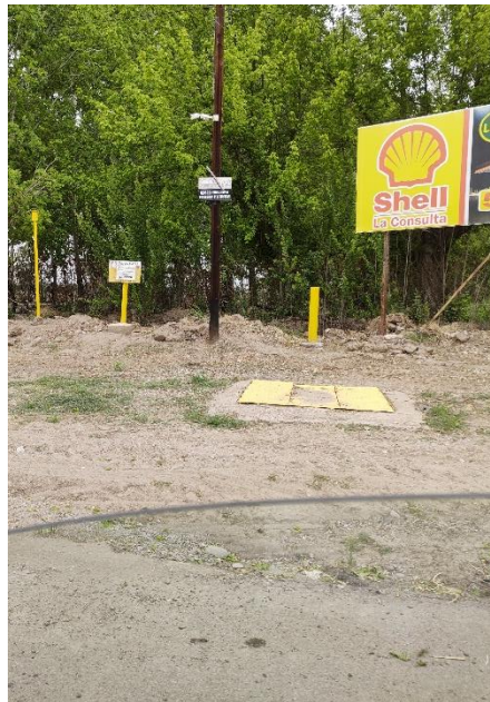
Registro fotográfico. Aviso paso traza gasoducto.
