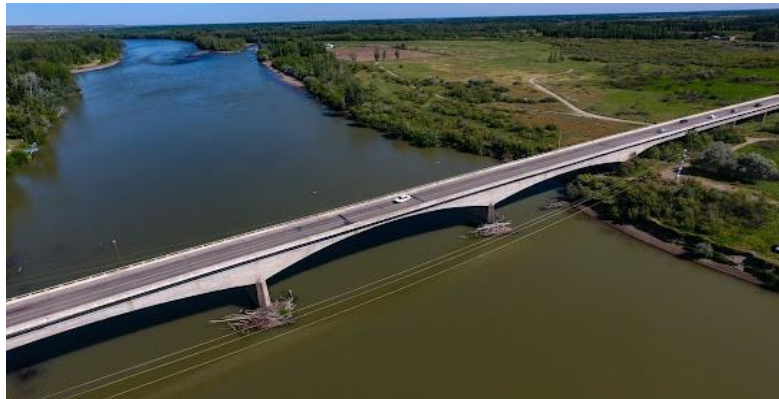
Registro Fotográfico: Puente carretero
