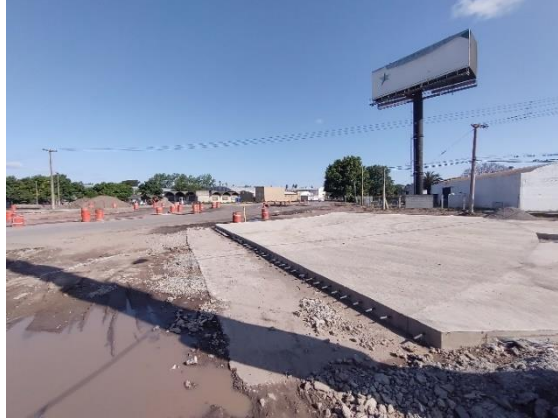
Registro Fotográfico: Inicio de traza, rotonda RP 2 y Av. Carranza. En obra.
