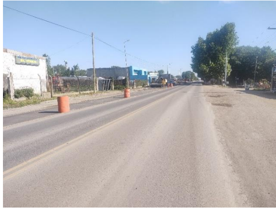
Registro Fotográfico: Traza continuación, RP 4 en obra.
