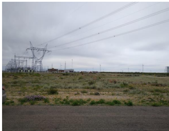
Registro Fotográfico: Central eléctrica, cruce de tendido
