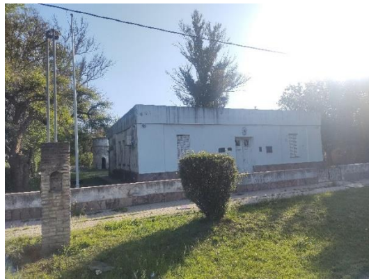
Registro Fotográfico: Finalización de traza. Escuela primaria Rural.
