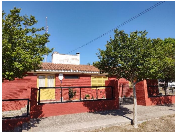
Registro Fotográfico: Traza continuación, Escuela Juan Larrea, Los Molinos.
