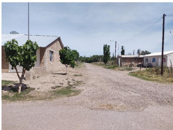
Registro Fotográfico: Traza continuación calle s/n.
