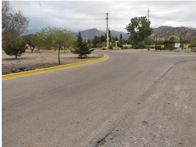
Registro fotográfico. Inicio de traza.
