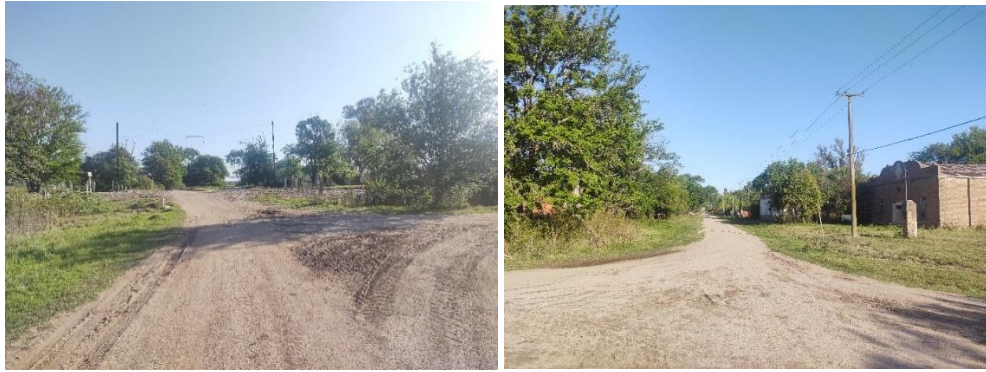
Registro Fotográfico: Cruce vía férrea (izquierda). Continuación traza calle s/n (derecha)
