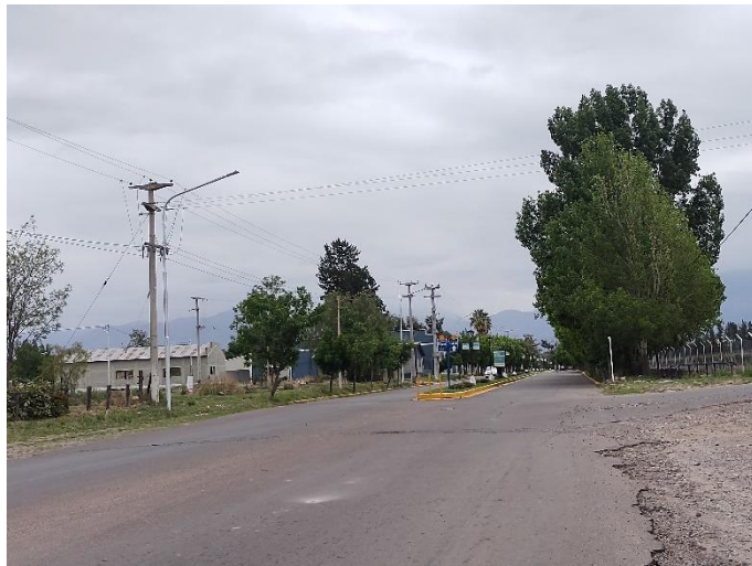
Registro fotográfico. Continuación traza RP95.
