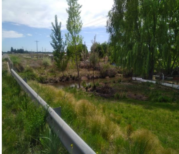
Registro Fotográfico: Puente desagüe
