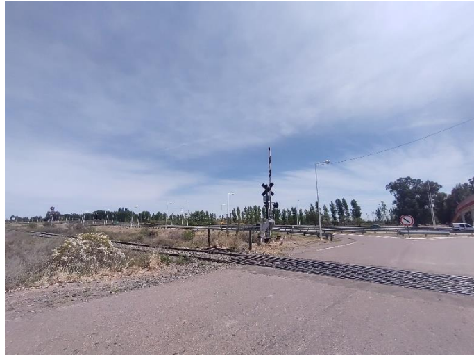
Registro Fotográfico: Vías férreas.
