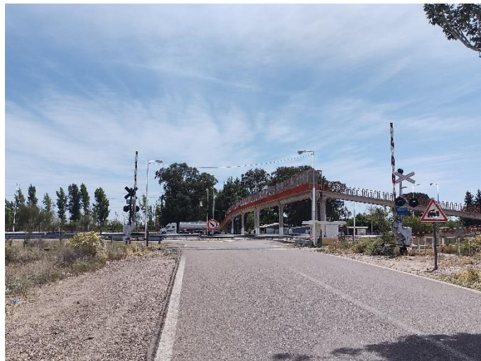
Registro Fotográfico: Vías férreas.
