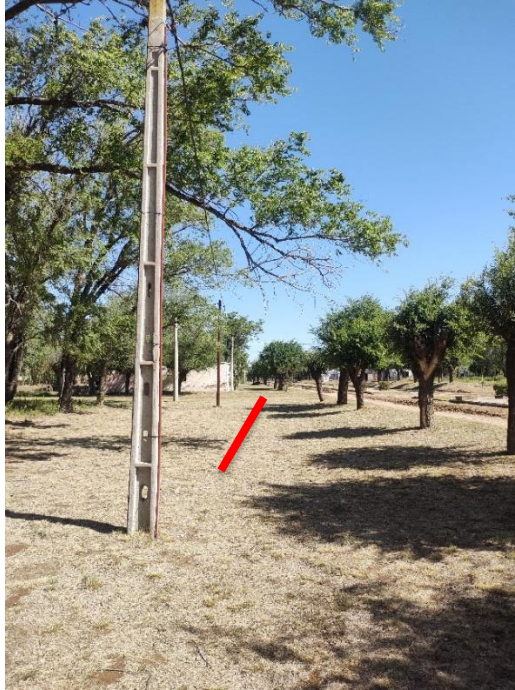
Registro Fotográfico: Finalización traza paralela a Bv. Washington, futuro sitio 3x3.
