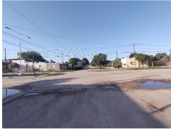
Registro Fotográfico. Continuación traza por barrios residenciales.
