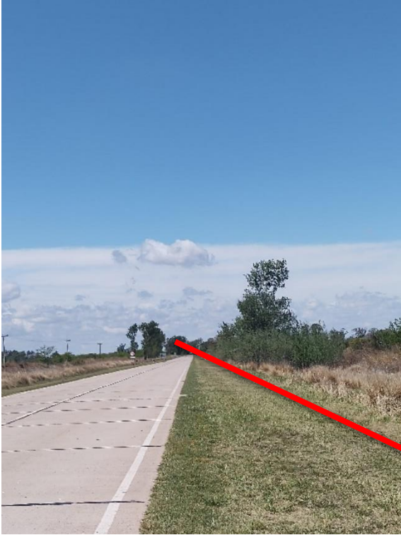
Registro Fotográfico: Continuación camino acceso La Cautiva. Cruce de traza.
