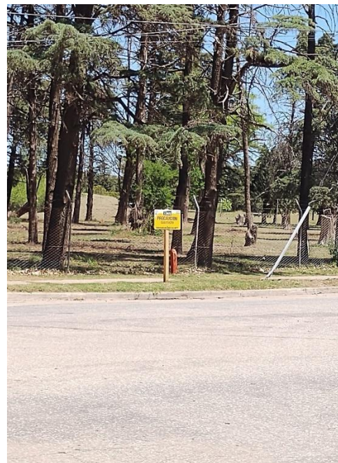
Registro Fotográfico: Advertencia traza gasoducto.
