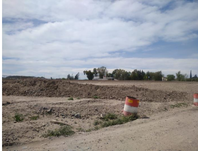
Registro Fotográfico: Obra en construcción (rotonda)
