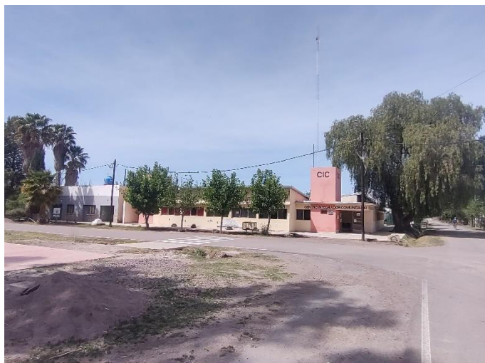
Registro Fotográfico: Inicio de traza.
