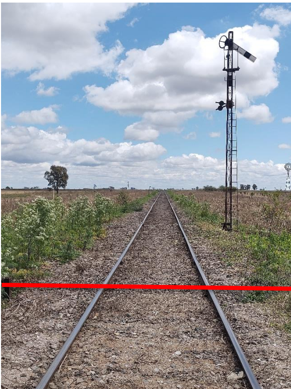
Registro Fotográfico: Calle San Martín, traza oeste, cruce de vías FC San Martín.
