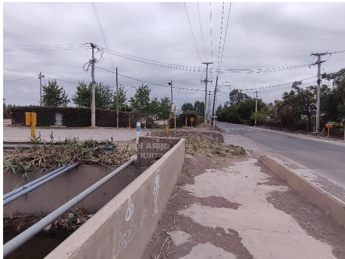
Registro fotográfico. Inicio de traza.
