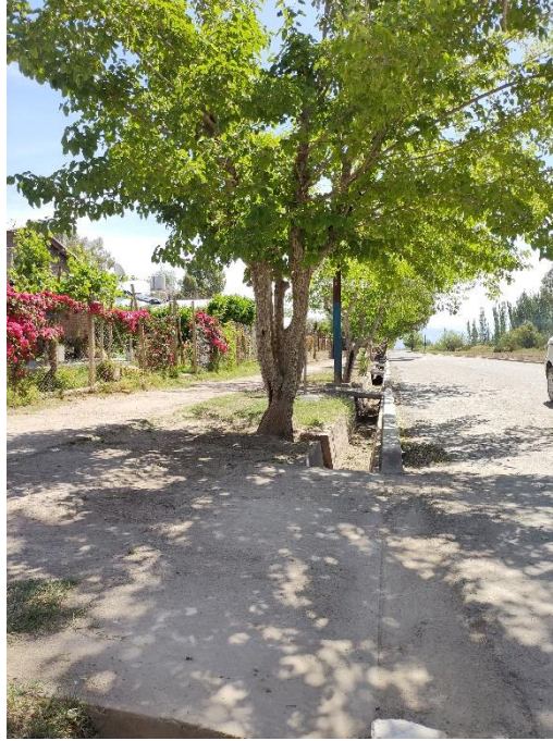
Registro Fotográfico: Inicio de traza, calle s/n, Barrio Lagunas de Bartoluzzi.
