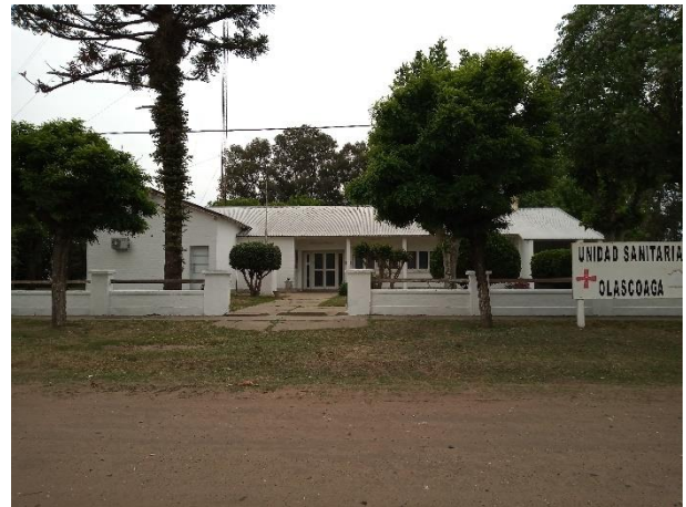
Registro Fotográfico: Unidad Sanitaria. Final de traza.
