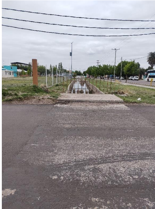
Registro fotográfico. Acequia.
