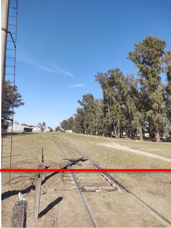
Registro Fotográfico: Cruce vías férreas.
