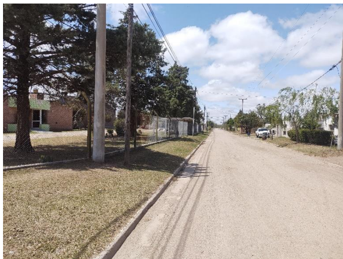
Registro Fotográfico: Finalización de traza Cooperativa de Obras y Servicios Públicos Ltda
