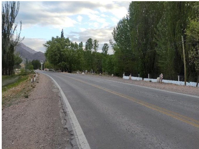
Registro fotográfico. Inicio de traza.
