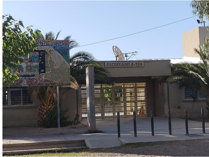
Registro Fotográfico: Escuela N° 4-194.
