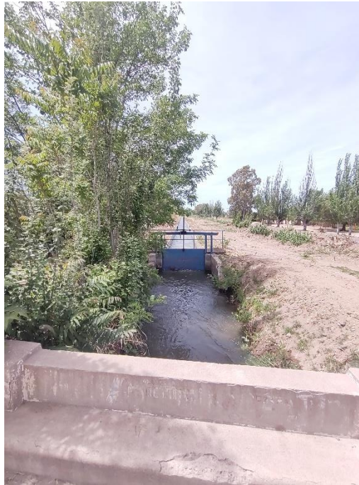
Registro Fotográfico: Cruce de acequia.
