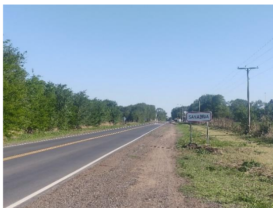
Registro Fotográfico: Ingreso localidad de Sanabria.
