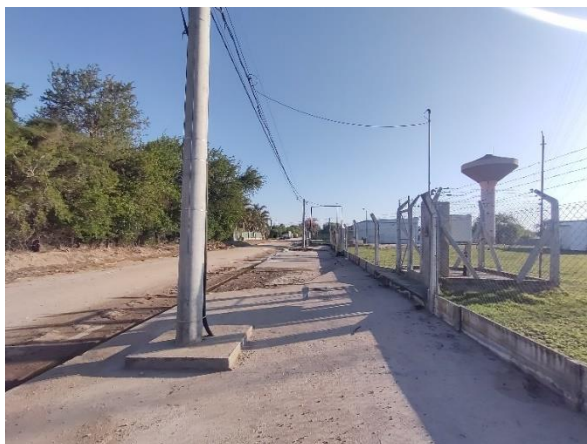
Registro Fotográfico. Inicio de traza, sitio Ballesteros, paralelo a calle Mercedes.
