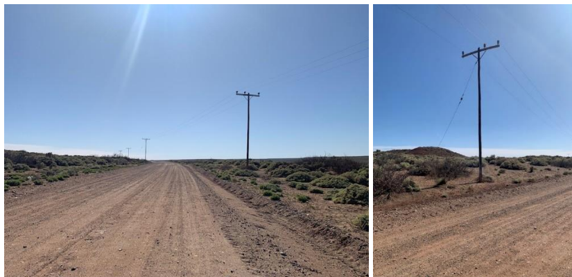
Registro Fotográfico: Cruce de línea eléctrica.
