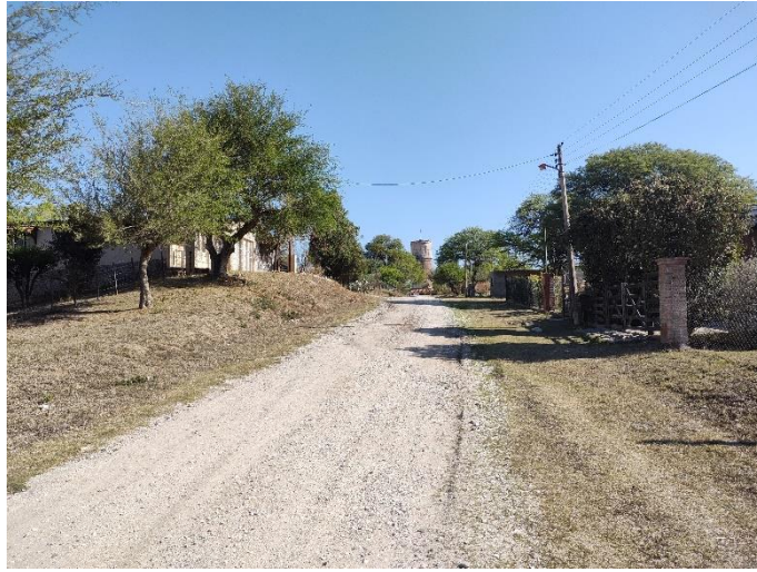
Registro Fotográfico: Inicio de traza en localidad de Villa San Isidro.
