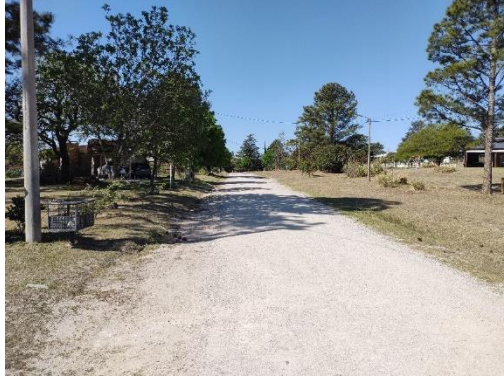
Registro Fotográfico: Inicio de traza.
