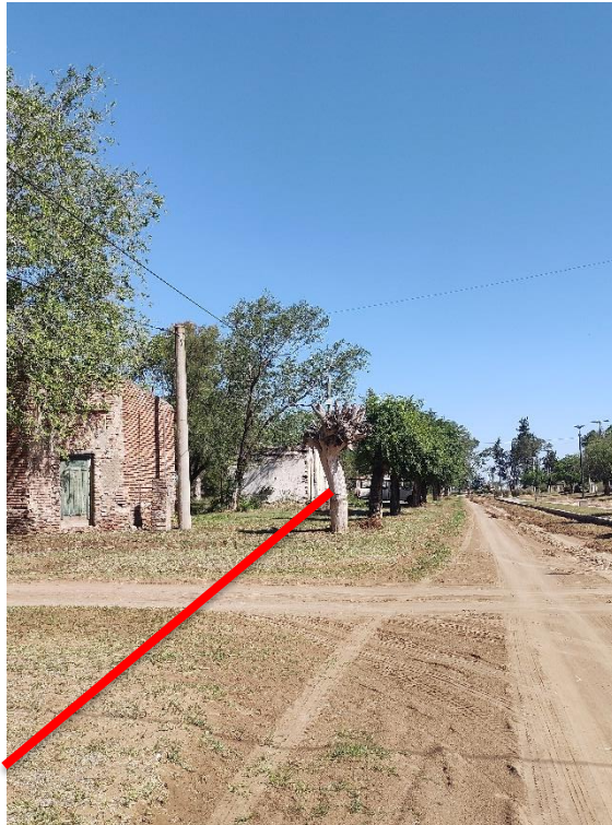
Registro Fotográfico: Traza paralela a Bv. Washington.
