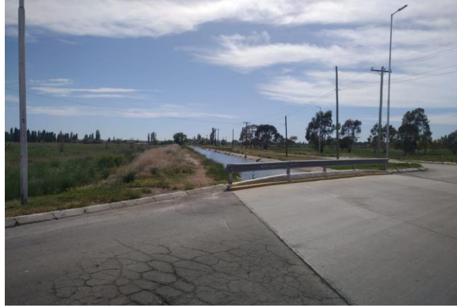
Registro Fotográfico: Puente canal de riego
