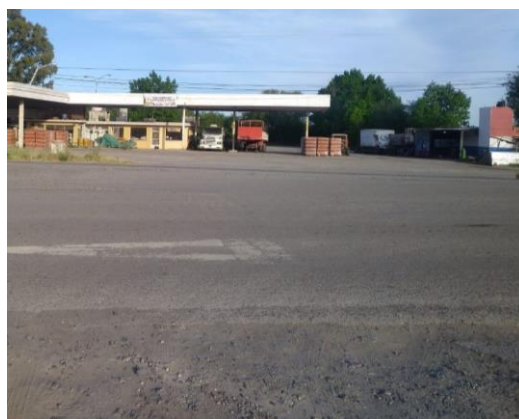
Registro Fotográfico: Cruce de tendido en RN 22
