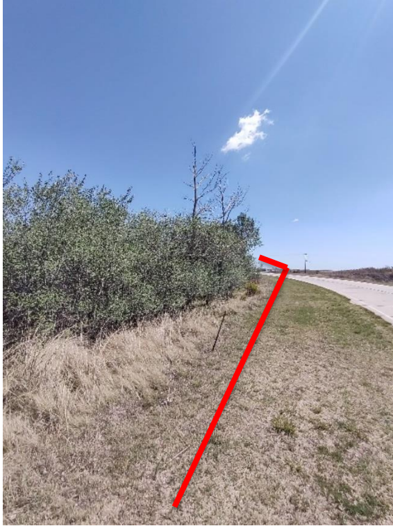
Registro Fotográfico: Continuación camino acceso La Cautiva.
