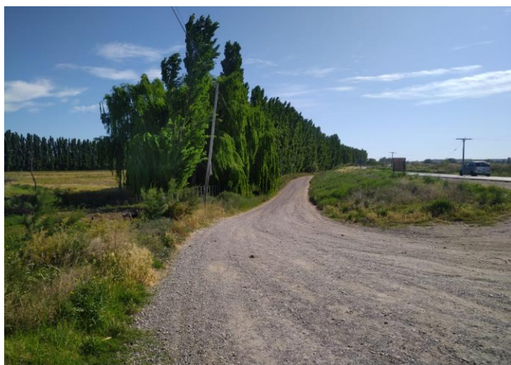
Registro Fotográfico: Tendido eléctrico del lado derecho de la ruta
