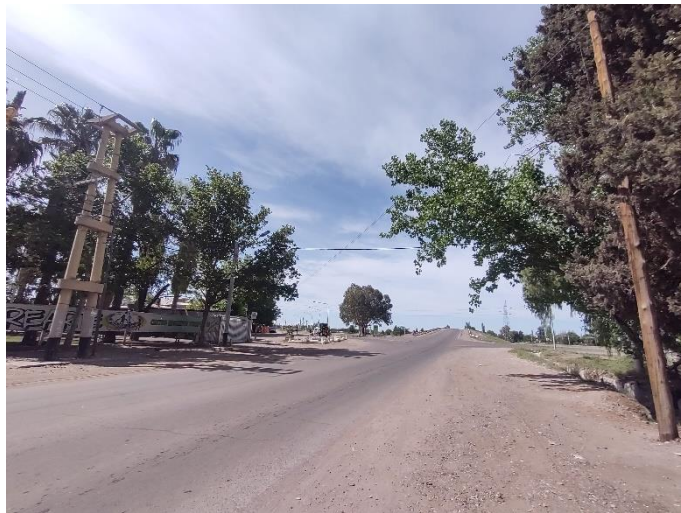
Registro Fotográfico: Calle Lavalle continuación de traza.
