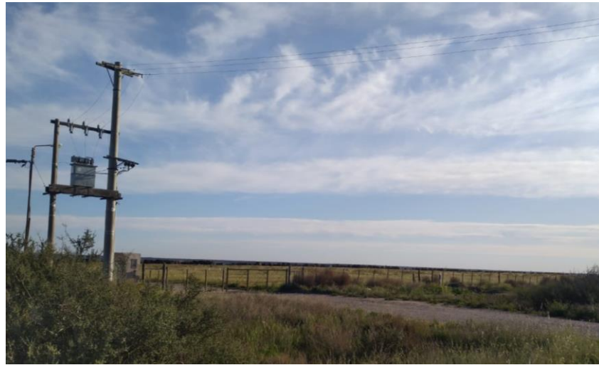
Registro Fotográfico: Tendido eléctrico
