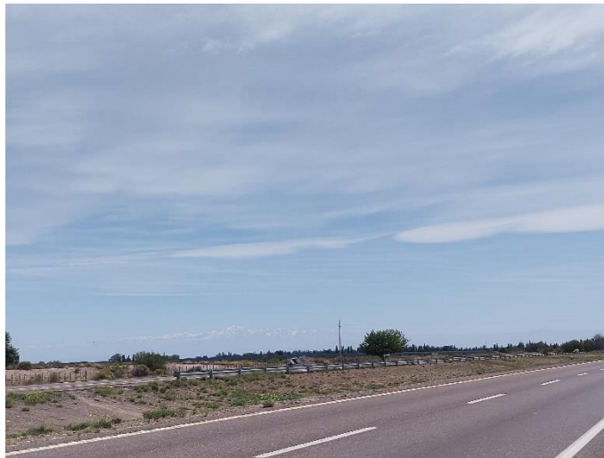
Registro Fotográfico: Cruce traza RN 7 (Acceso este).
