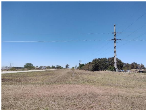
Registro Fotográfico: Inicio de traza.
