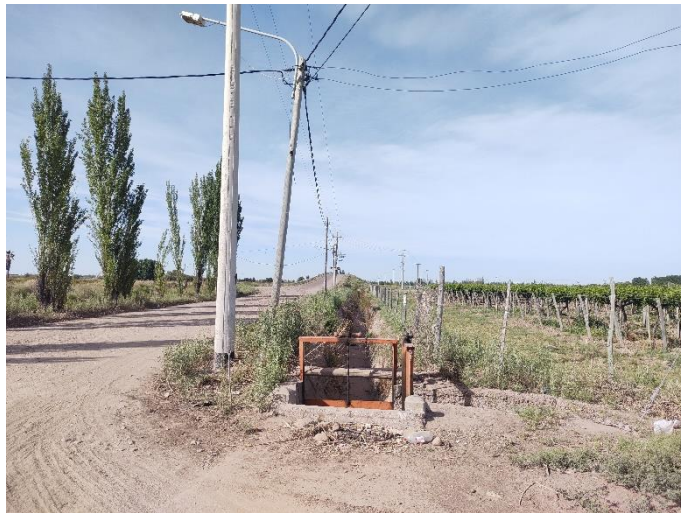
Registro fotográfico. Continuación por calle San Pedro. Acequía paralela.
