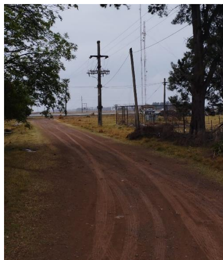
Registro Fotográfico: Vista hacia la autopista.
