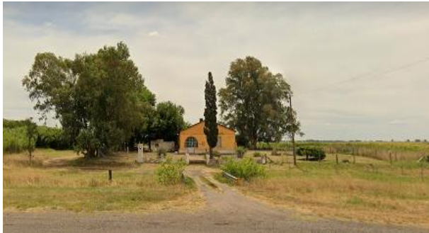
Registro Fotográfico: Inicio de traza. CEA N°5.
