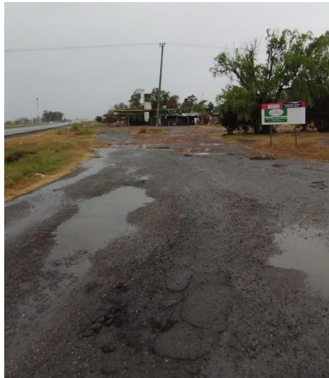
Registro Fotográfico: Vista del camino mejorado.
