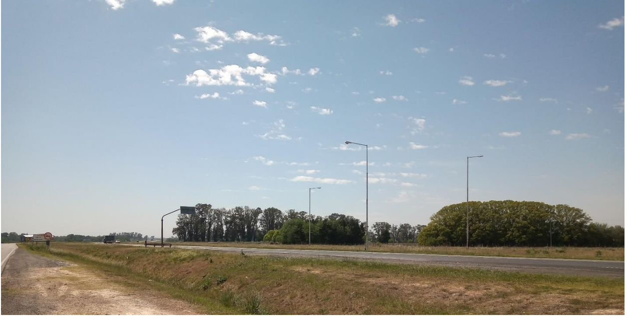
Registro Fotográfico: Interferencia: Autopista 5.
