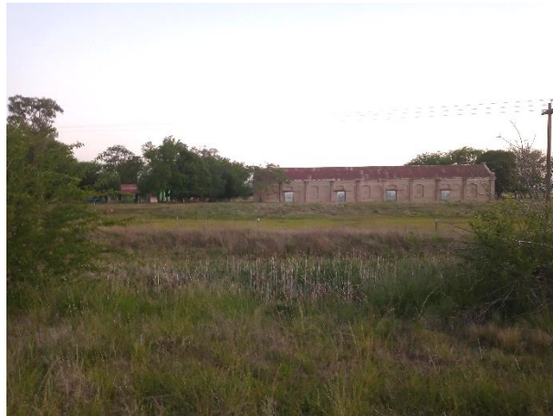
Registro Fotográfico: Entorno camino provincial 093-13. Edificio abandonado de ferrocarril.
