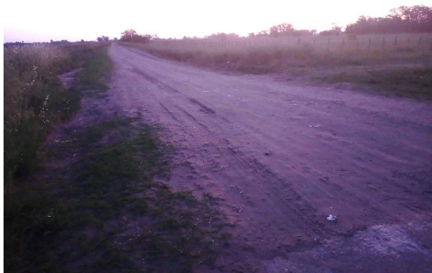
Registro Fotográfico: Entorno caminos rurales en la zona de la traza.
