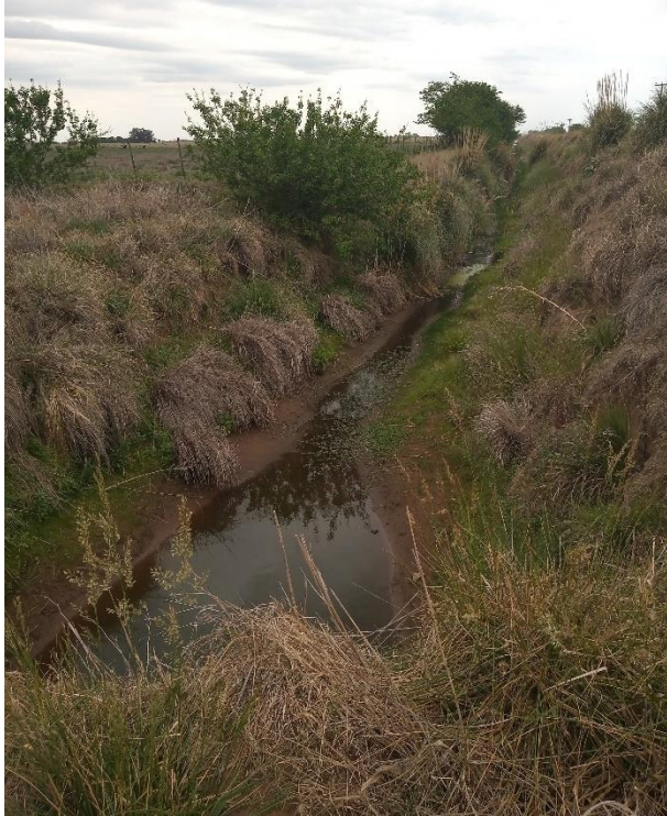
Registro Fotográfico: Canal paralelo a la traza.
