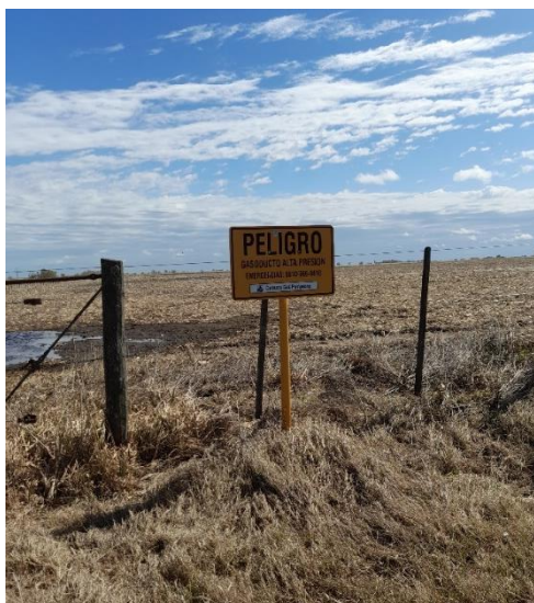
Registro Fotográfico: Línea de gasoducto de alta presión a la altura del cruce con RP46
