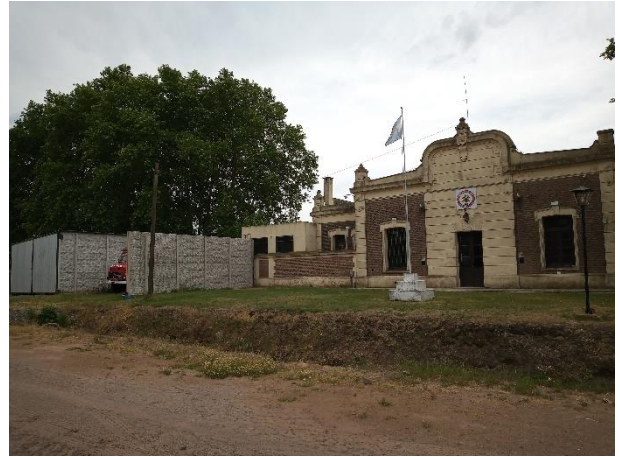
Registro Fotográfico: Estación de Bomberos.
