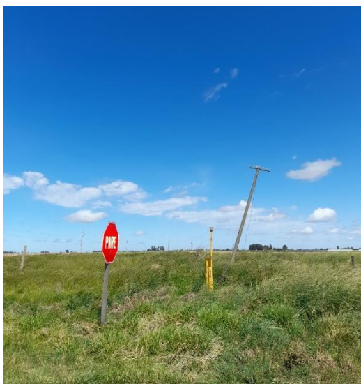
Registro Fotográfico: Marcadores de la línea de gasoducto de alta presión.
