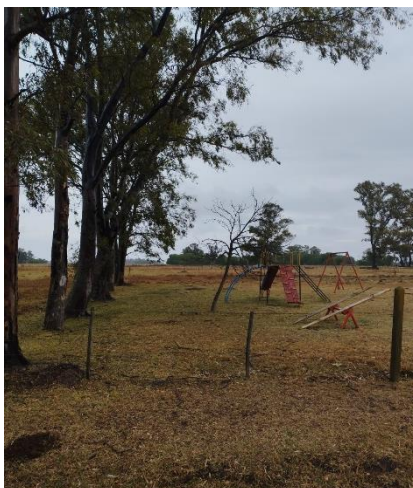
Registro Fotográfico: vista de la zona donde se construirá el sitio de 3 x 3 dentro de la Escuela N°21.
