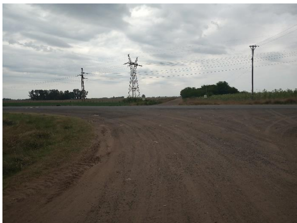
Registro Fotográfico: Entorno inicio de traza. Cruce RP 46 y camino de acceso a Asamblea.
