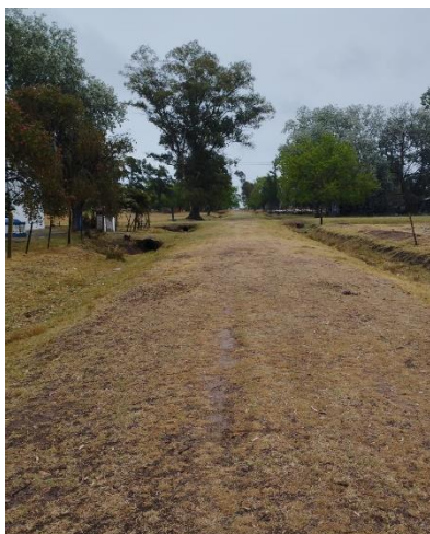
Registro Fotográfico: Vista de camino de tierra.
