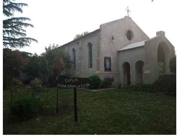
Registro Fotográfico: Capilla.
