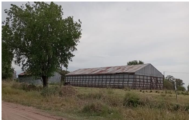
Registro Fotográfico: Zona de ingreso de la traza a Comodoro Py. Galpones.
