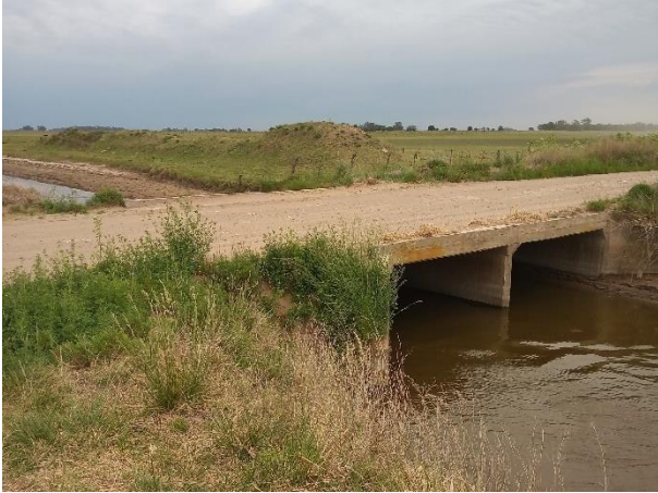
Registro Fotográfico: Canal a cruzar, situado a 3,5 km del inicio de traza.
