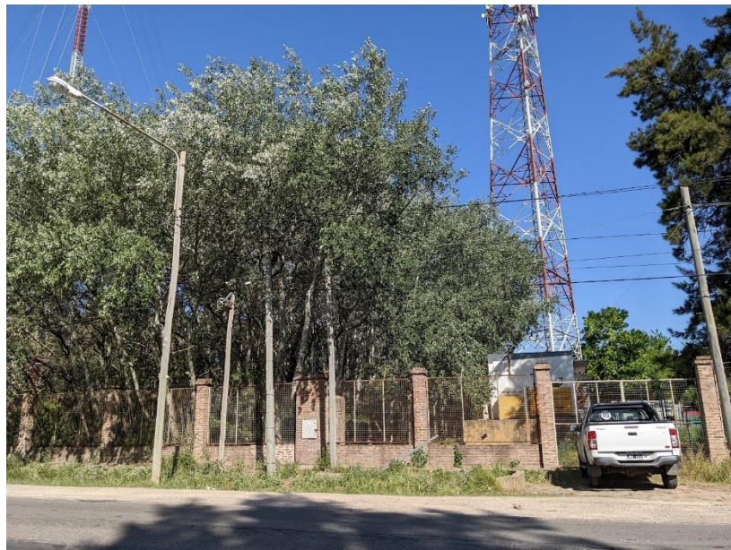
Registro Fotográfico: Finalización de traza. Lugar del sitio Chacras de Río Luján, progresiva 3083 m de la traza.
