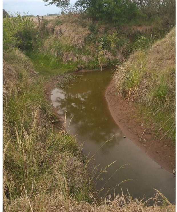
Registro Fotográfico: Canal. Posible interferencia.
