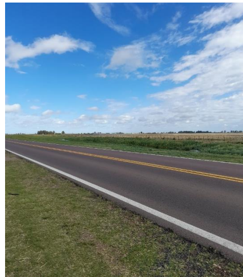
Registro Fotográfico: Ruta Provincial 46. Final del tramo.
