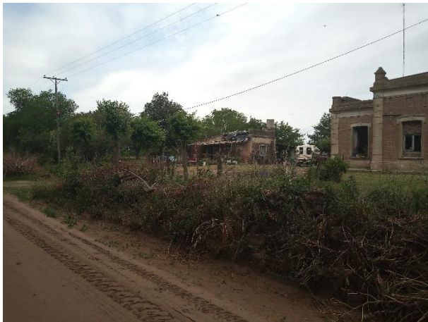
Registro Fotográfico: Vivienda precaria en las inmediaciones de la escuela. Estación abandonada de ferrocarril.
