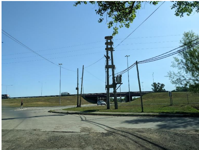
Registro Fotográfico: Tramo inicial: cruce subterráneo de RN9 con tunelera dirigida (300 metros).
