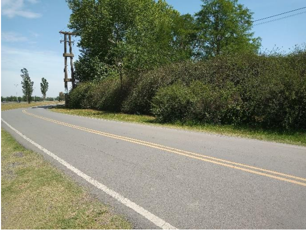
Registro Fotográfico: Calzada pavimentada.
