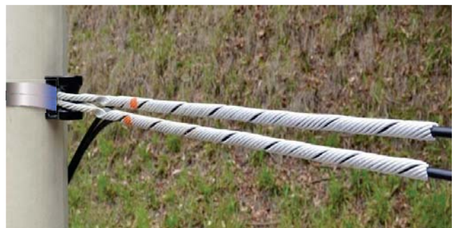
Instalación del Soporte de Retención
