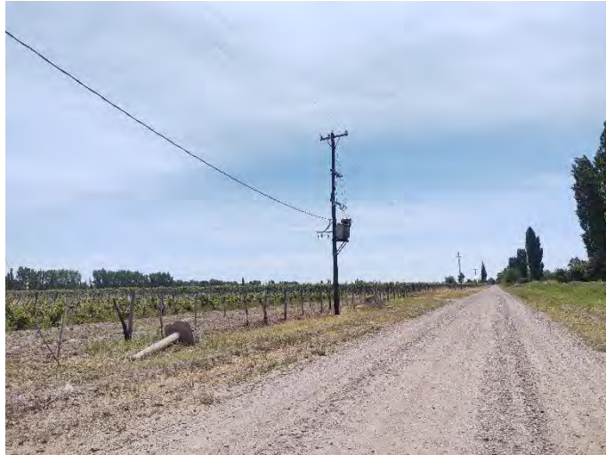
Registro Fotográfico: Calle s/n continuación traza.
