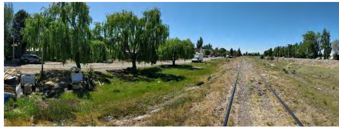
Registro Fotográfico: Interferencia de la traza con las vías del ferrocarril línea Roca.
