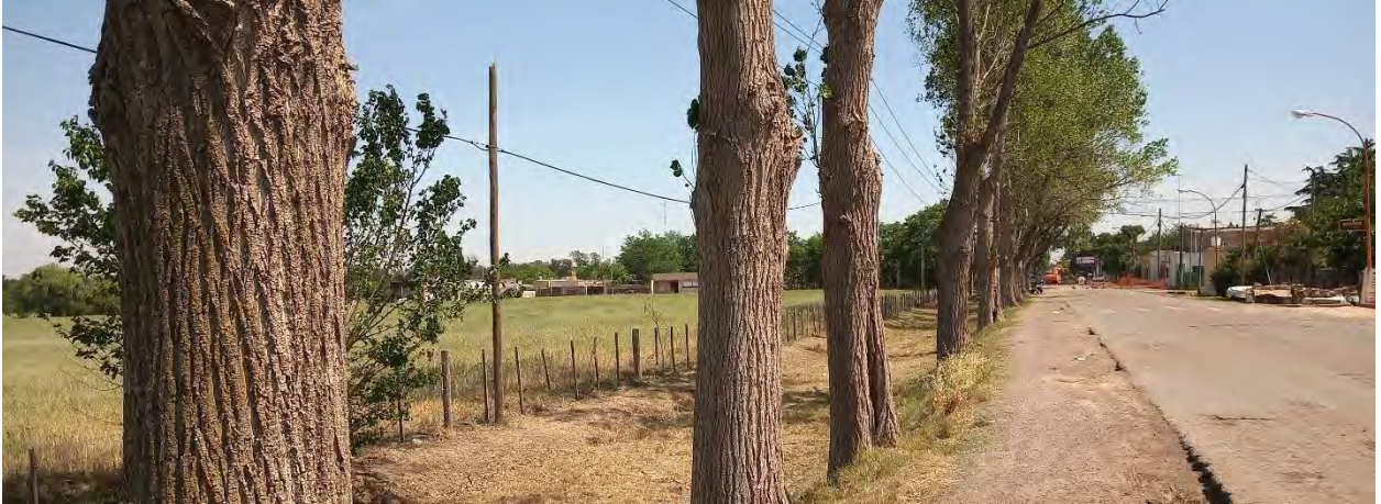
Registro Fotográfico: Calle 25 de Mayo. Últimos 200 metros de la traza.
