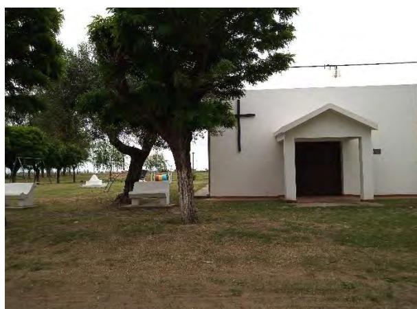
Registro Fotográfico: Iglesia y parque recreativo.
