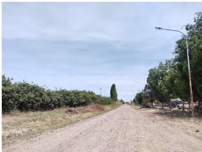
Registro Fotográfico: Continuación calle s/n.
