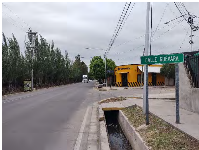
Registro fotográfico. Continuación traza calle Adriano Gómez.
