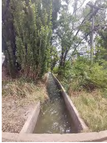
Registro Fotográfico: Cruce de acequia.
