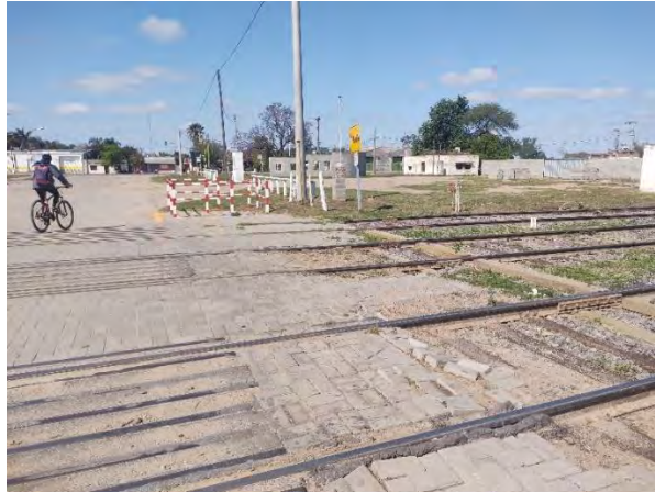
Registro Fotográfico: Continuación traza, cruce vías férreas, calle Malvinas Argentinas.
