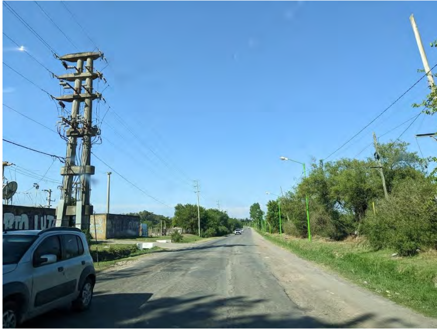
Registro Fotográfico: Subestación transformadora (izquierda) adyacente a la avenida, progresiva 1600 m de la traza.
