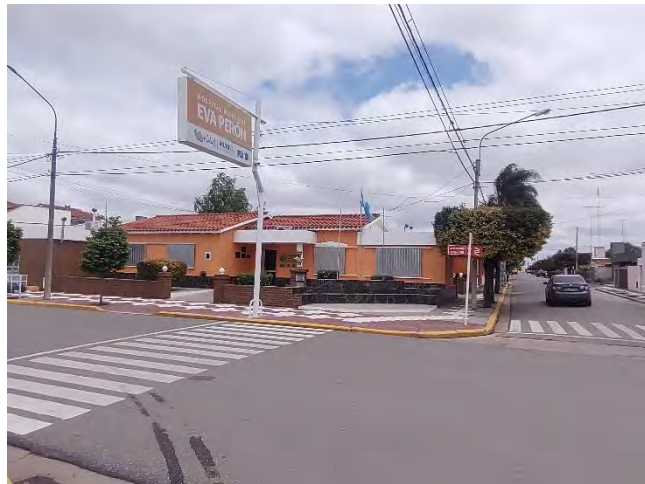
Registro Fotográfico: Traza, Hospital "Eva Perón", calle Saavedra y Av. San Martín.
