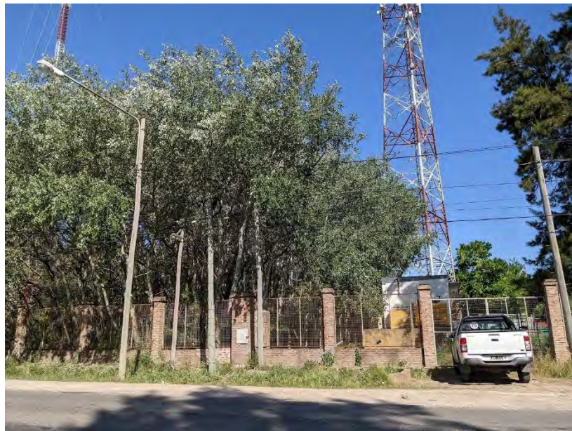
Registro Fotográfico: Finalización de traza. Lugar del sitio Chacras de Río Luján, progresiva 3083 m de la traza.
