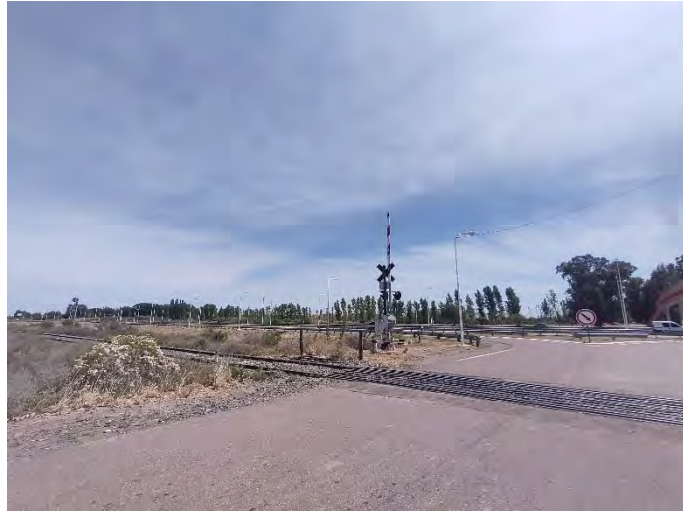
Registro Fotográfico: Vías férreas.
