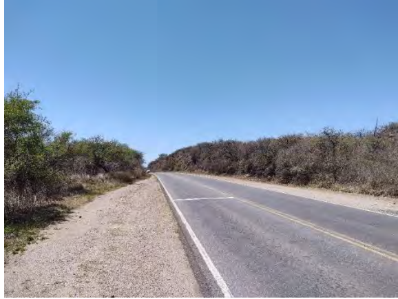
Registro Fotográfico: Elevación en ambos lados de la ruta.
