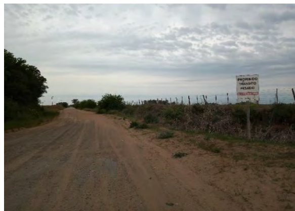
Registro Fotográfico: Entorno inicio de traza. Cruce RN 5 y camino de acceso a Olascoaga.
