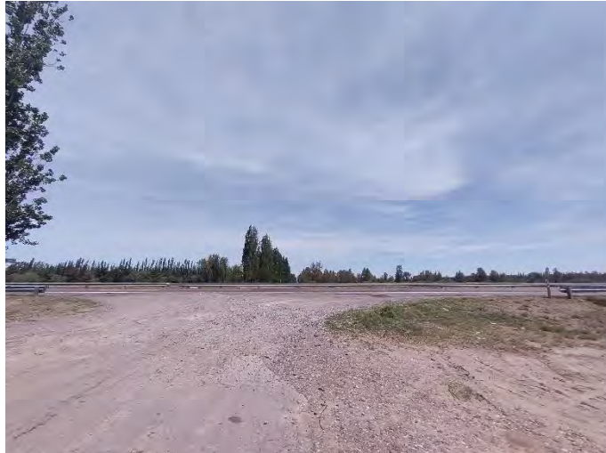
Registro Fotográfico: Cruce traza RN 7 (Acceso este).
