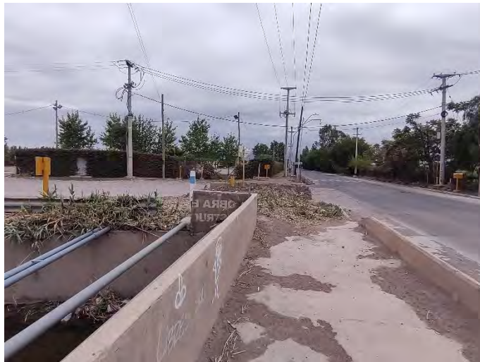
Registro fotográfico. Inicio de traza.
