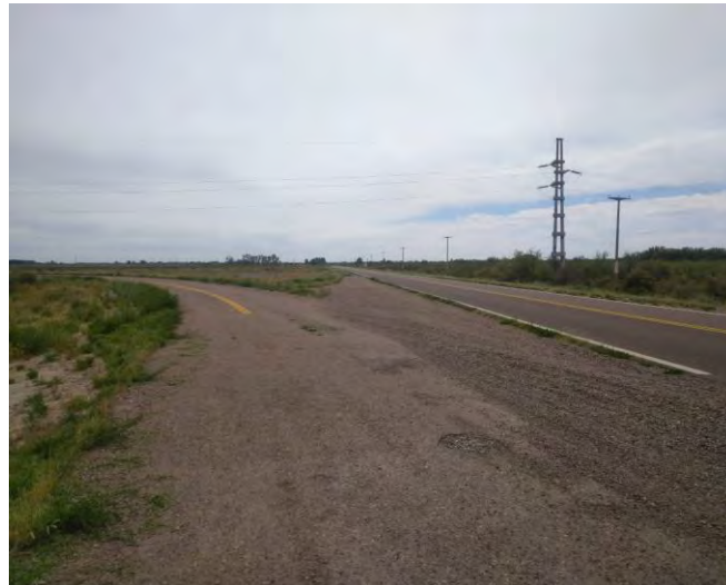
Registro Fotográfico: Cruce tendido eléctrico
