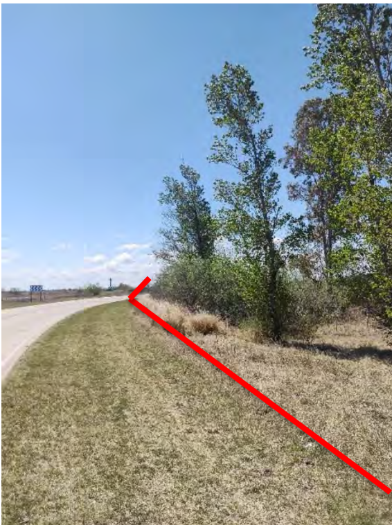
Registro Fotográfico: Continuación camino acceso La Cautiva, primera curva.
