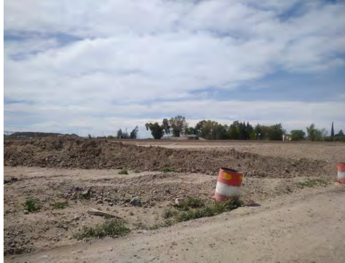
Registro Fotográfico: Obra en construcción (rotonda)
