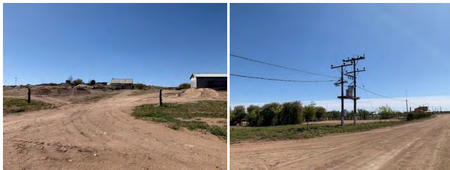
Registro Fotográfico: Acceso a zona ferroviaria (izquierda) y transformador (derecha)
