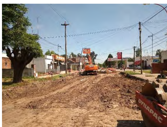
Registro Fotográfico: Entorno de final de la traza. Movimiento de maquinaria.
