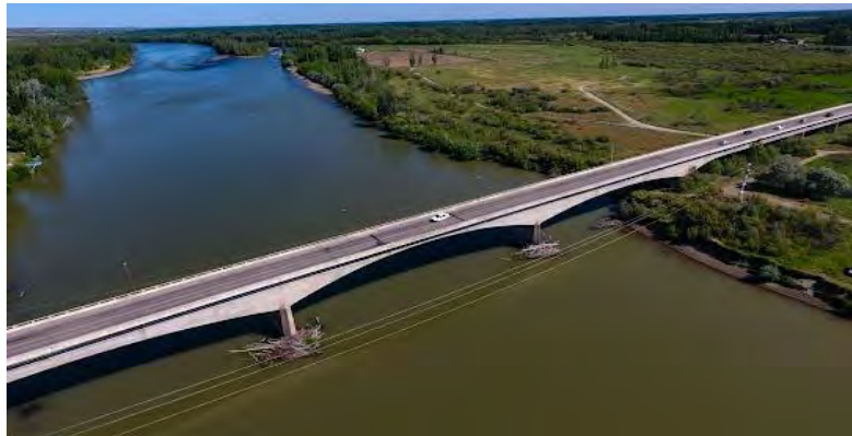
Registro Fotográfico: Puente carretero
