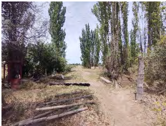
Registro Fotográfico: Finalización traza, cruce acequia.
