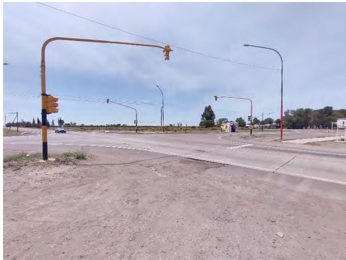
Registro Fotográfico: Continuación traza intersección RP 71 y RP 50.
