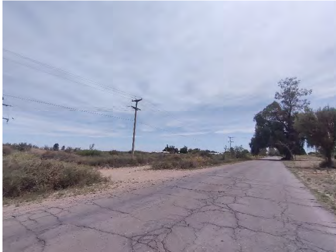
Registro Fotográfico: Intersección de RP 50 y calle s/n.
