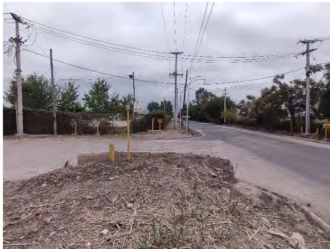
Registro fotográfico. Planta de tratamiento de efluentes FECOVITA. Paso traza conducto gas.
