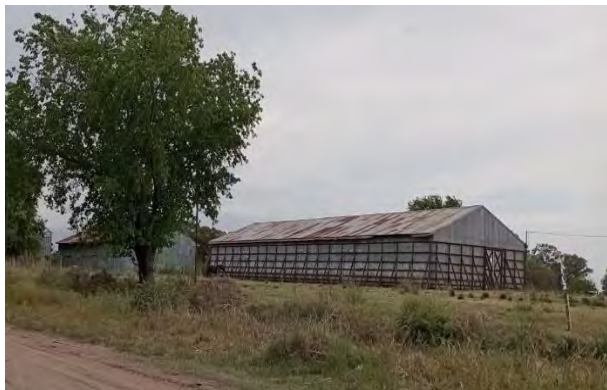
Registro Fotográfico: Zona de ingreso de la traza a Comodoro Py. Galpones.
