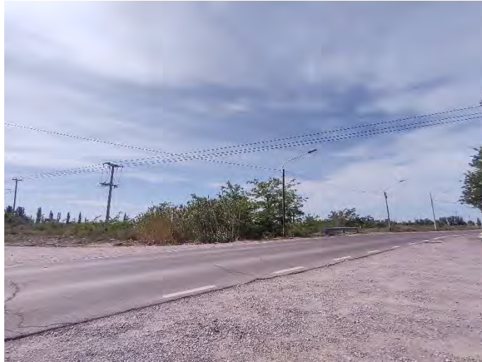
Registro Fotográfico: Intersección calle Chivilcoy y Montecaseros.
