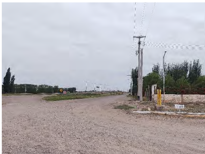
Registro fotográfico. Continuación calle s/n. Trazado gasoducto.
