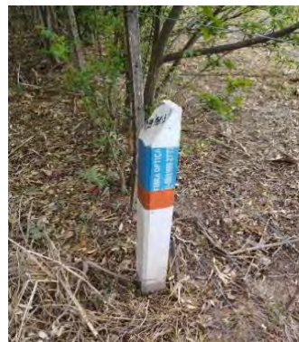
Registro Fotográfico: Mojón de punto de Interconexión.
