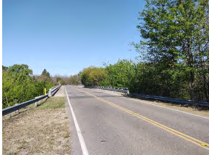
Registro Fotográfico: Cruce traza, puente sobre RP E56.
