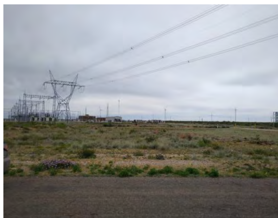
Registro Fotográfico: Central eléctrica, cruce de tendido
