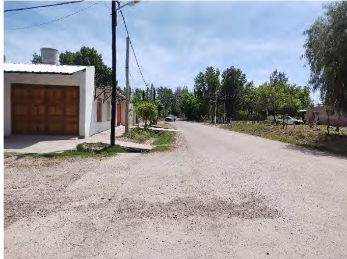
Registro Fotográfico: Continuación traza por calle s/n.
