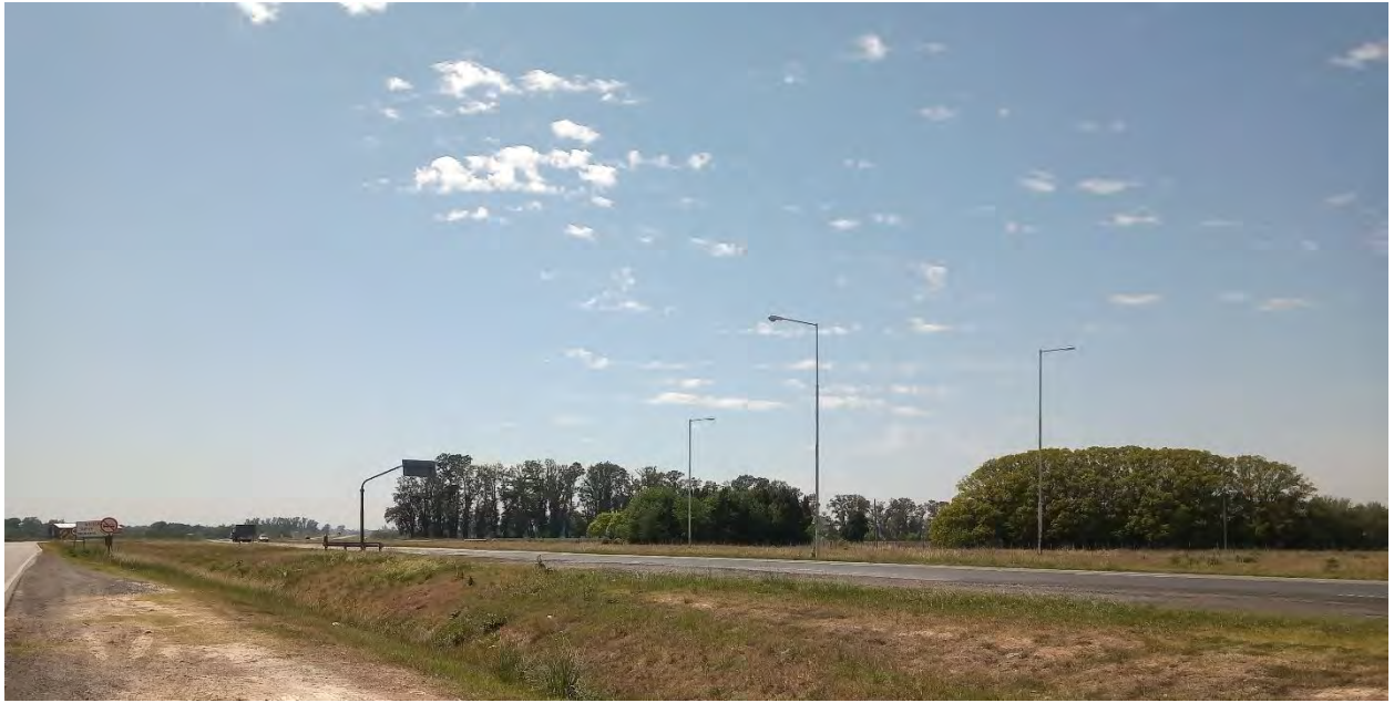
Registro Fotográfico: Interferencia: Autopista 5.
