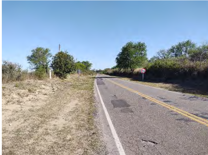
Registro Fotográfico: Continuación traza paralela a RP E56. Arbustos y arboles nativos durante la traza.
