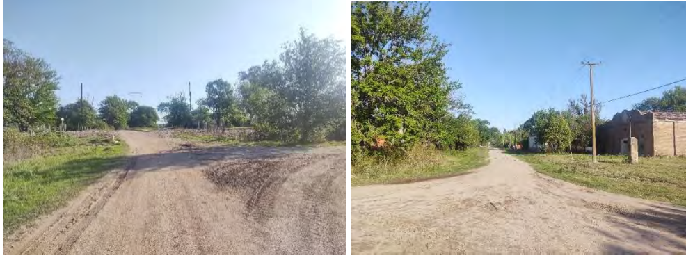
Registro Fotográfico: Cruce vía férrea (izquierda). Continuación traza calle s/n (derecha)
