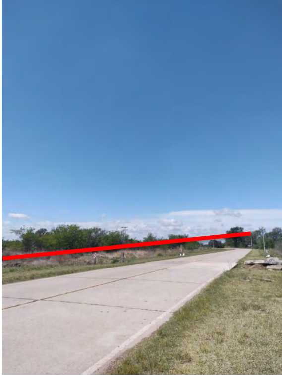
Registro Fotográfico: Continuación camino acceso La Cautiva.
