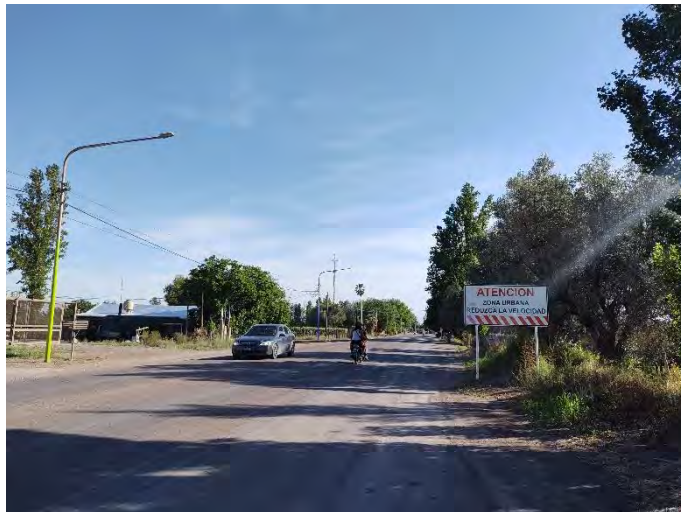
Registro Fotográfico: Continuación de traza por RN 142, ingresando a zona urbana.
