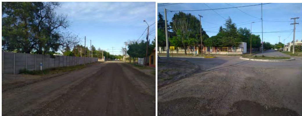
Registro Fotográfico: Comienzo de camino pavimentado y rotonda
