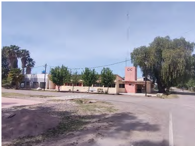
Registro Fotográfico: Inicio de traza.
