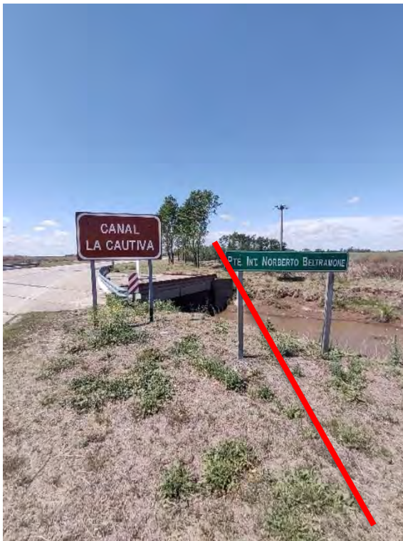
Registro Fotográfico: Cruce Canal La Cautiva (Arroyo del Gato).
