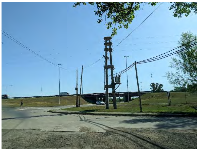
Registro Fotográfico: Tramo inicial: cruce subterráneo de RN9 con tunelera dirigida (300 metros).
