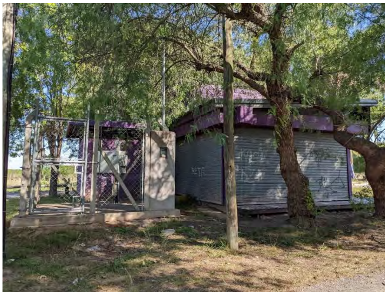
Registro Fotográfico: Inicio de traza.
