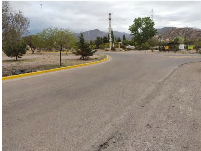
Registro fotográfico. Inicio de traza.
