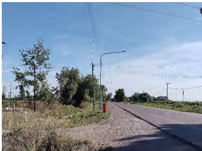
Registro Fotográfico: Inicio de traza, paralela a RN 142.
