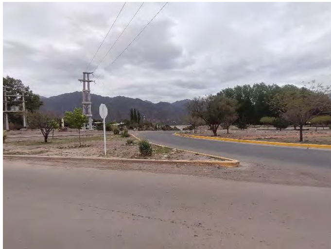
Registro fotográfico. Continuación de la traza, rotonda RP89.
