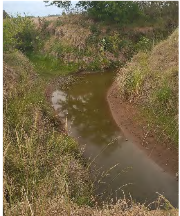
Registro Fotográfico: Canal. Posible interferencia.
