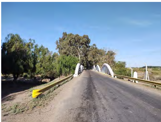
Registro Fotográfico: Cruce puente Río Mendoza.
