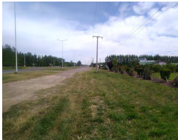
Registro Fotográfico: Tendido eléctrico RN 250
