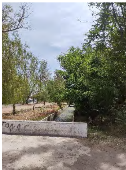
Registro Fotográfico: Acequia sobre calle C. Suarez.
