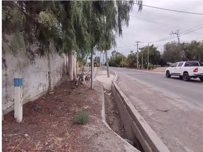
Registro fotográfico. Inicio de traza.
