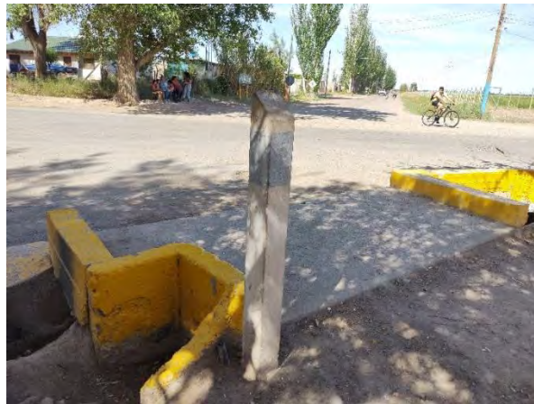
Registro Fotográfico: Finalización de la traza Esq. San Martín y Gral. Hacha.
