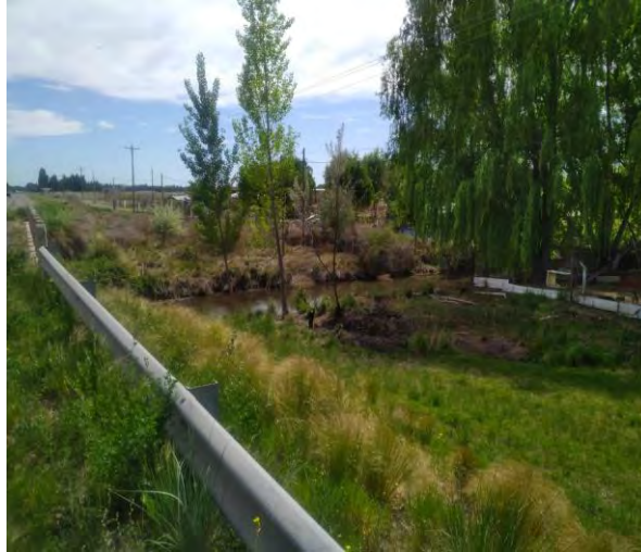
Registro Fotográfico: Puente desagüe
