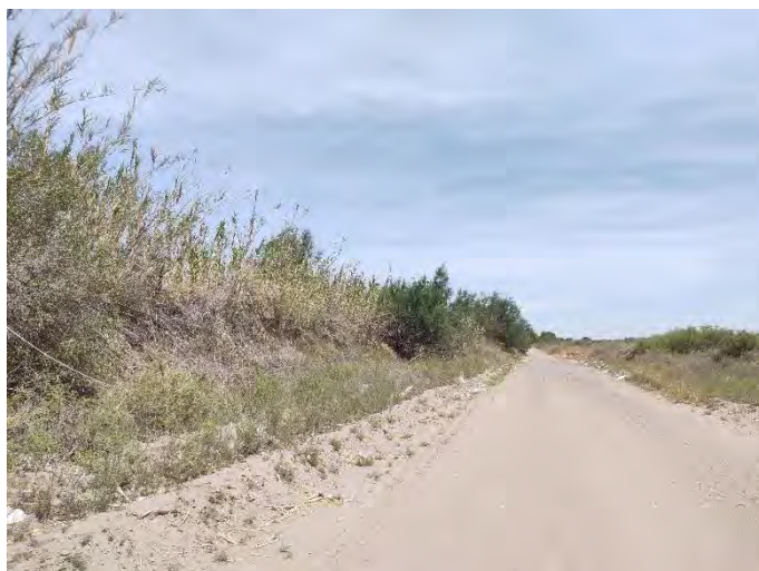
Registro Fotográfico: Continuación calle s/N.
