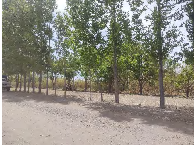
Registro Fotográfico: Inicio de traza.
