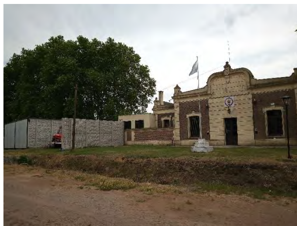
Registro Fotográfico: Estación de Bomberos.
