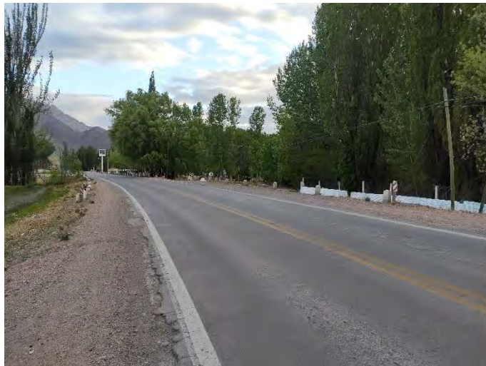
Registro fotográfico. Inicio de traza.
