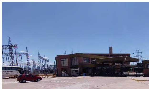
Registro Fotográfico: Ingreso a la Central Nuclear Embalse.
