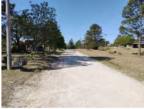
Registro Fotográfico: Inicio de traza.
