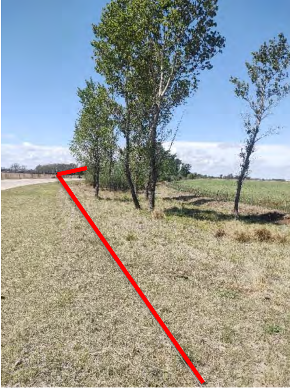
Registro Fotográfico: Continuación camino acceso La Cautiva.
