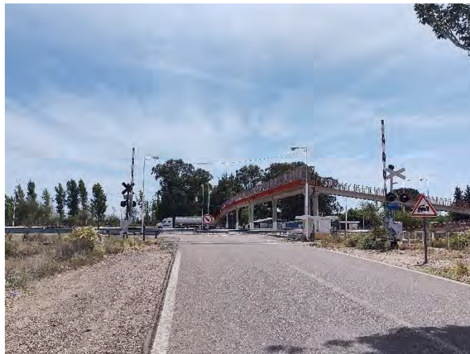
Registro Fotográfico: Vías férreas.
