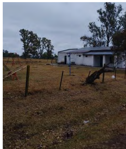
Registro Fotográfico: Vista hacia el patio de la Escuela N° 21.
