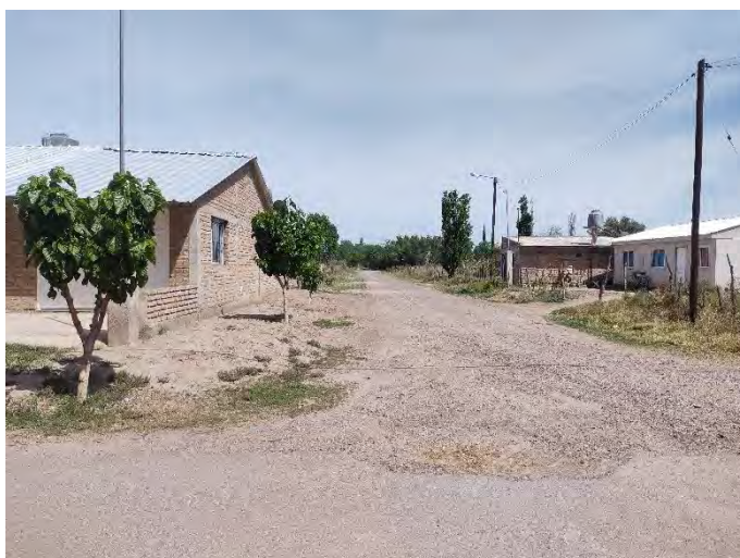
Registro Fotográfico: Traza continuación calle s/n.
