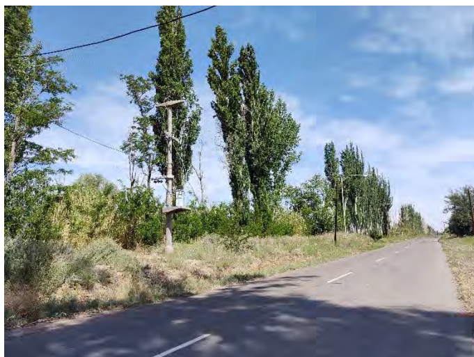
Registro Fotográfico: Calle San Juan, tendido eléctrico.
