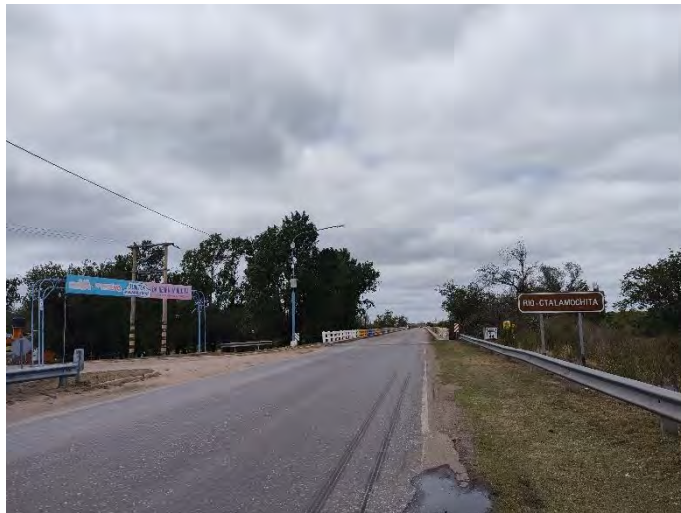
Registro Fotográfico: Cruce traza RP E79, Puente Río Ctalamochita (Río Tercero).
