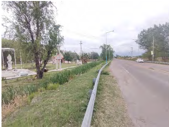
Registro fotográfico. Inicio de traza.
