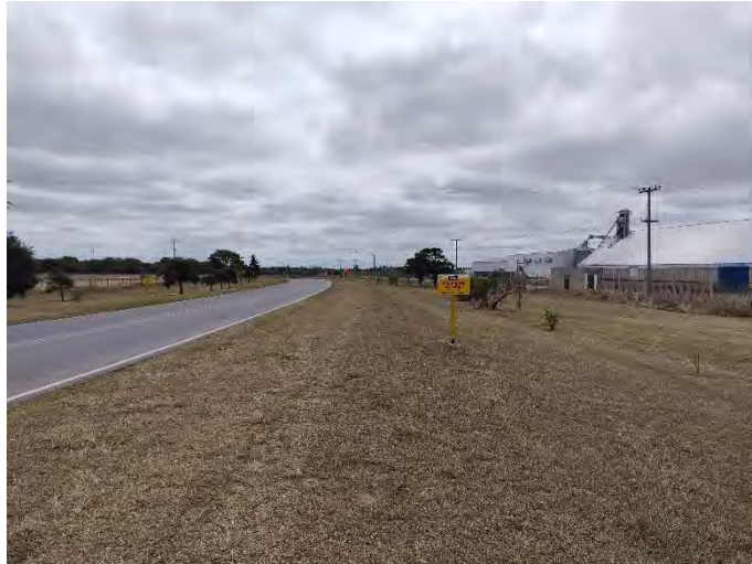
Registro Fotográfico: RP E79, aviso traza gasoducto.
