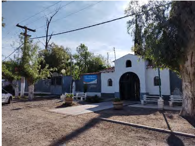
Registro Fotográfico: Cementerio “Costa de Araujo”.
