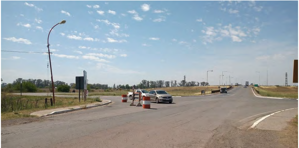
Registro Fotográfico: Cruce de Colectora Norte y calle 25 de Mayo. Ingreso a la localidad de Jáuregui.
