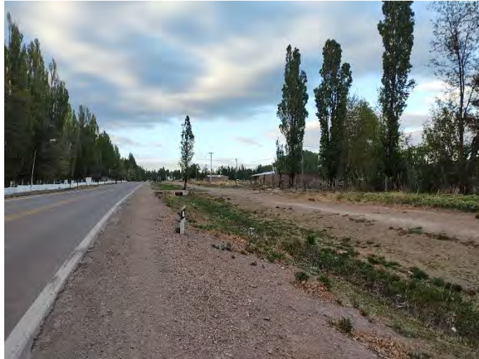
Registro fotográfico. Inicio de traza.
