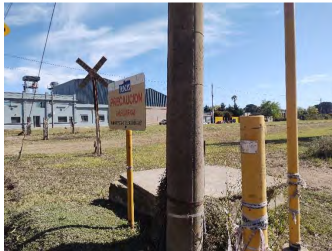
Figura 92. Continuación traza, calle Lavalle norte. Cruce vías férreas. Aviso gasoducto
