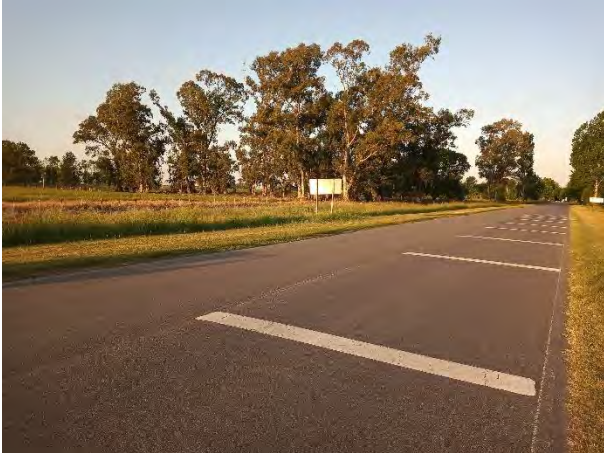
Registro Fotográfico: Entorno Camino provincial 093-13.
