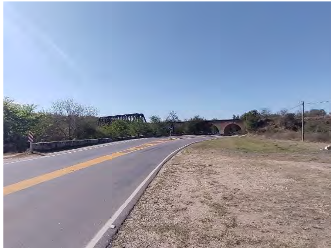
Registro Fotográfico: Cruce ramal (abandonado) RP E56.
