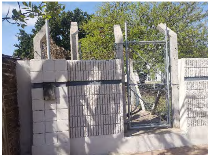
Registro Fotográfico: Sitio ubicado en 32°10'3.63"S; 63°27'52.92"O, calle San Pablo.
