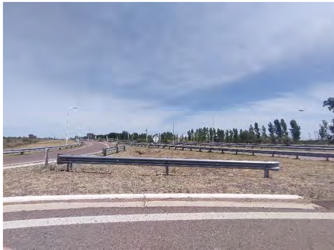
Registro Fotográfico: Finalización de la traza RN 7 (Acceso este)
