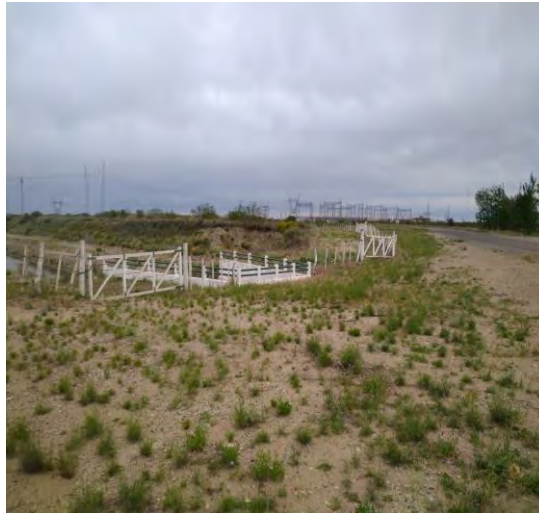
Registro Fotográfico: Puente canal de riego
