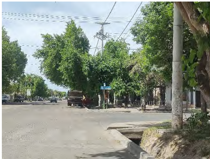
Registro Fotográfico: Continuación traza por calle Lavalle.
