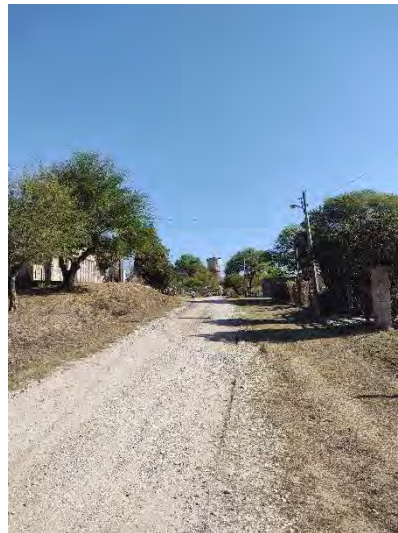
Registro Fotográfico: Finalización de la traza.
