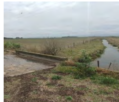
Registro Fotográfico: Cruce de arroyo.
