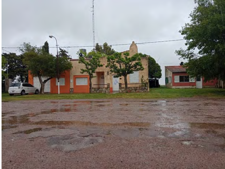
Registro Fotográfico: Entorno donde se tiene prevista la construcción del Sitio
