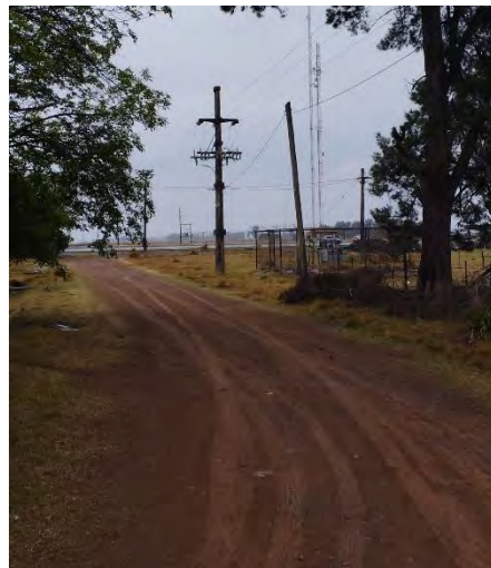
Registro Fotográfico: Vista hacia la autopista.
