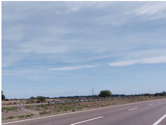
Registro Fotográfico: Cruce traza RN 7 (Acceso este).
