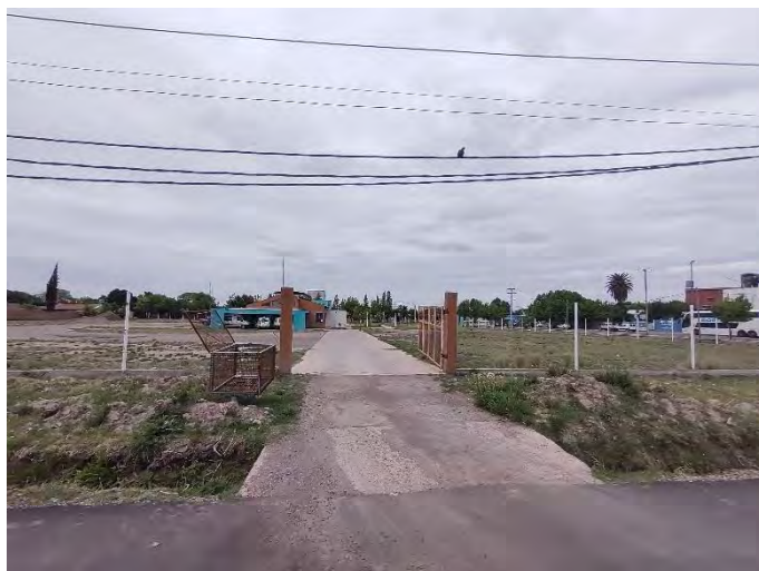
Registro fotográfico. Finalización traza. Micro hospital.
