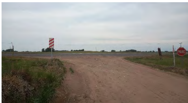
Registro Fotográfico: Entorno inicio de traza. Cruce RN 5 y camino de acceso a Olascoaga.
