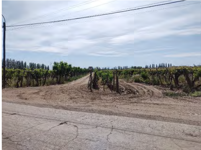
Registro Fotográfico: Finalización de la traza.
