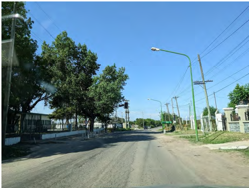
Registro Fotográfico: Escuela Primaria N° 4 y Escuela Secundaria N° 8 (izquierda) adyacente a la avenida, progresiva 1660 m de la traza
