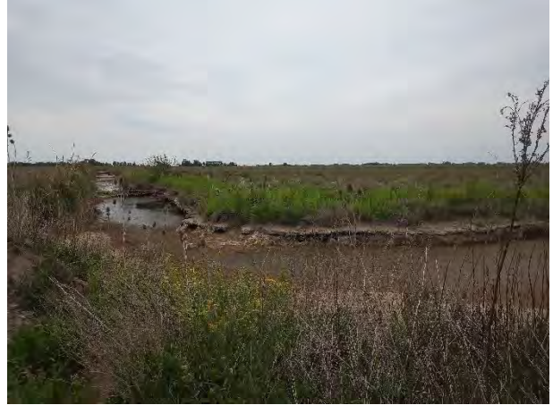
Registro Fotográfico: Canal paralelo al desarrollo de la traza.
