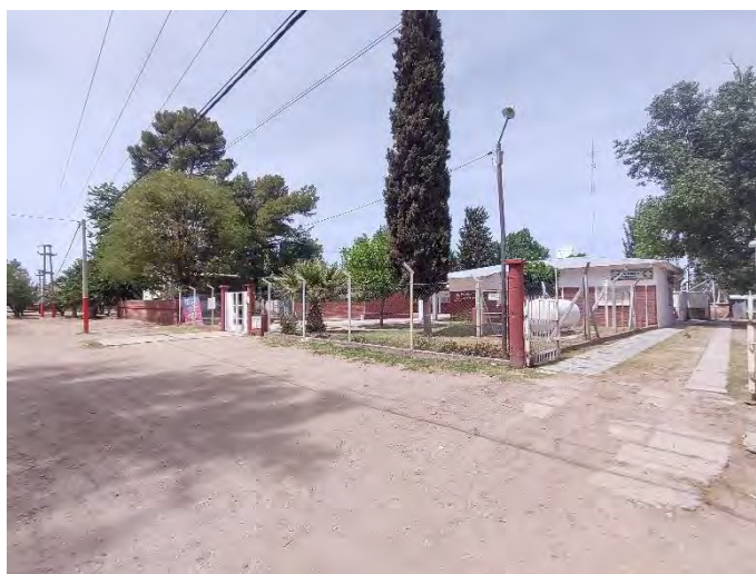
Registro Fotográfico: Inicio de traza.
