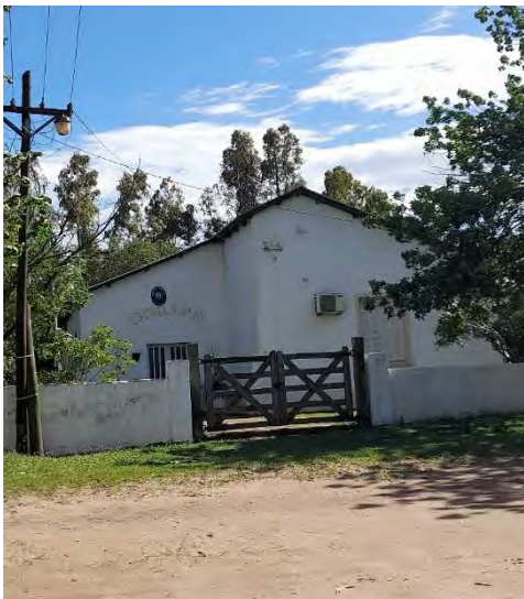
Registro Fotográfico: Escuela N°10. Tramo inicial.
