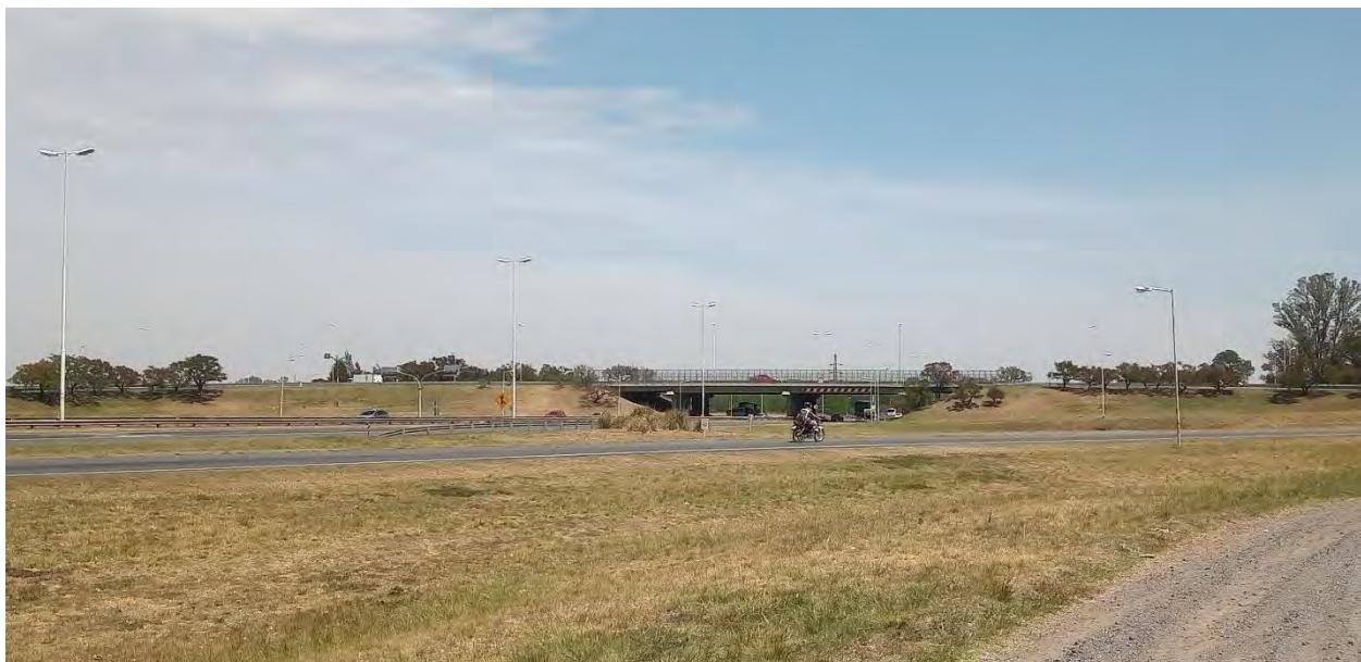
Registro Fotográfico: Entorno de inicio de traza. Cruce Autopista con RP 6 (puente).
