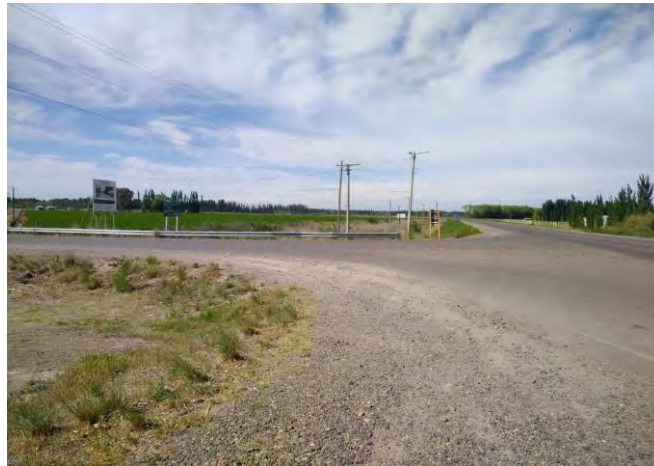
Registro Fotográfico: Cruce camino pavimentado
