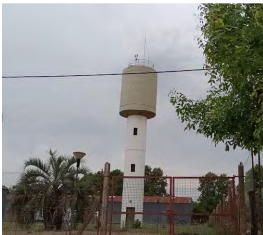
Registro Fotográfico: Zona de ingreso de la traza a Comodoro Py. Tanque elevado.
