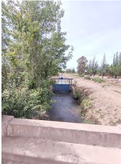
Registro Fotográfico: Cruce de acequia.
