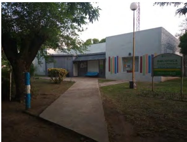
Registro Fotográfico: Biblioteca municipal de Álvarez de Toledo.
