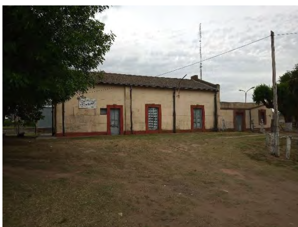
Registro Fotográfico: Centro Intercultural de Promoción de la Salud. Lindante con línea de ferrocarril.
