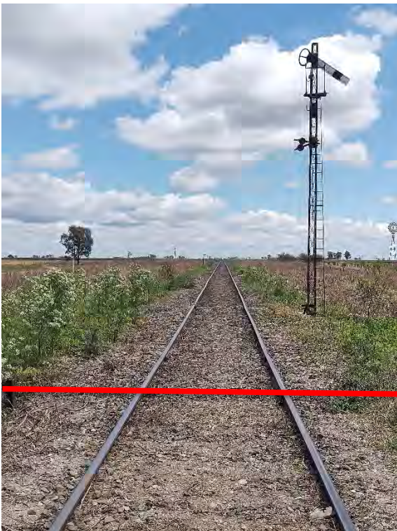
Registro Fotográfico: Calle San Martín, traza oeste, cruce de vías FC San Martín.
