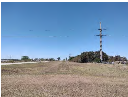
Registro Fotográfico: Inicio de traza.
