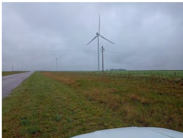
Registro Fotográfico: Línea de 132 kV.
