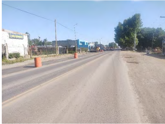
Registro Fotográfico: Traza continuación, RP 4 en obra.
