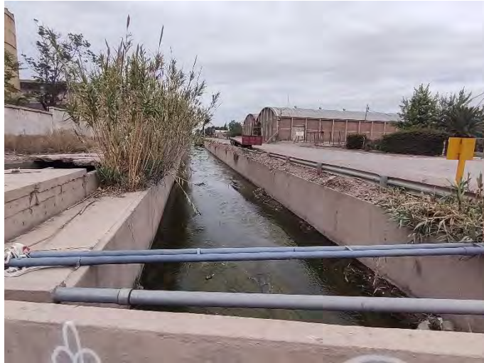
Registro fotográfico. Acequia inicio de traza.
