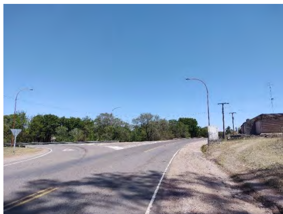
Registro Fotográfico: Cruce de RP5, finalización RP E63.
