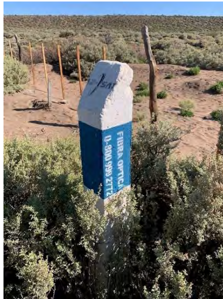
Registro Fotográfico: Mojón de Fibra Óptica.
