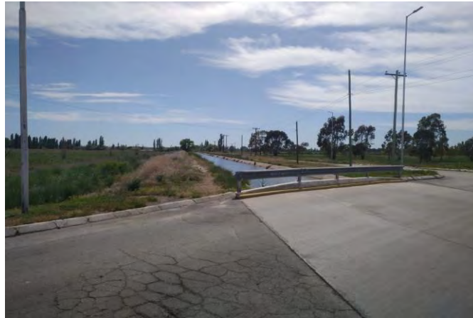
Registro Fotográfico: Puente canal de riego
