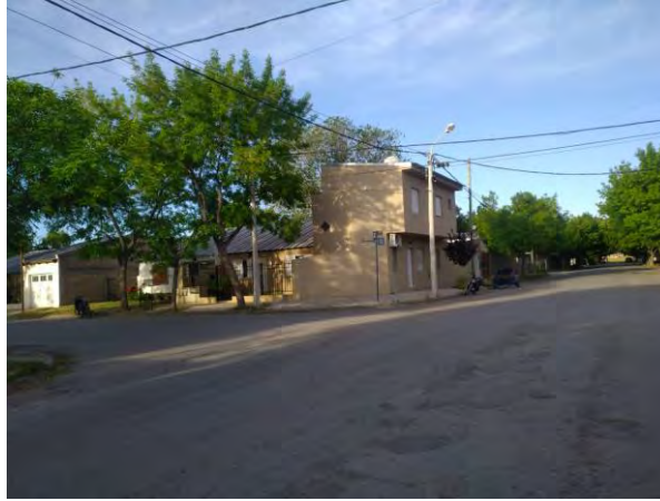
Registro Fotográfico: Camino Pavimentado y viviendas
