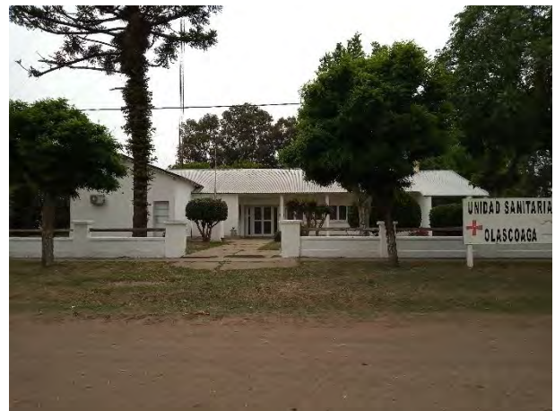
Registro Fotográfico: Unidad Sanitaria. Final de traza.
