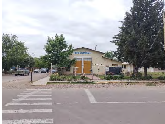
Registro fotográfico. Capilla María Auxiliadora
