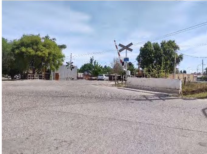
Registro Fotográfico: Cruce vía férrea, calle Perrupato.
