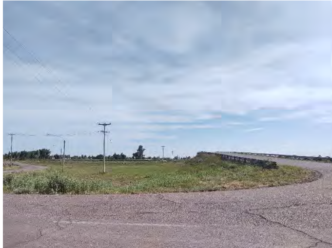
Registro fotográfico. Inicio de traza.
