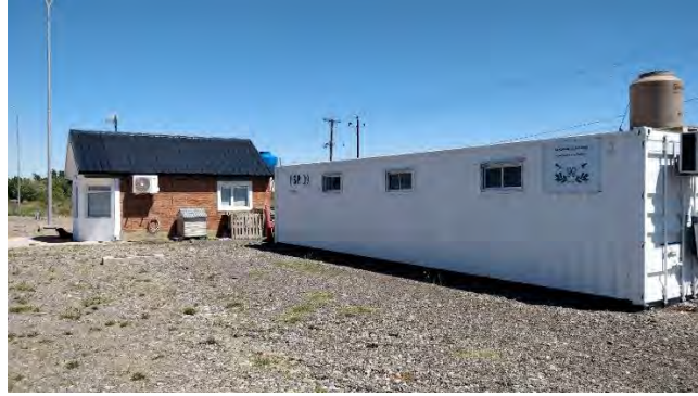
Registro Fotográfico: Instalaciones perteneciente a Gendarmería Nacional.
