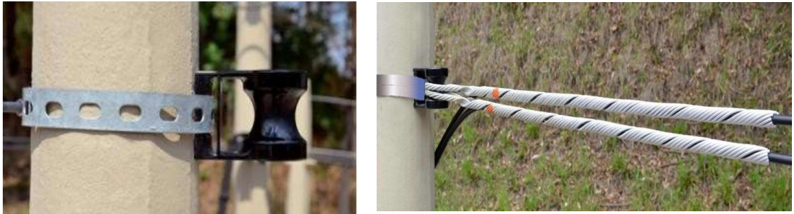
Instalación del Soporte de Retención
